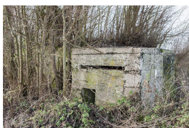
Vue générale, vers le nord-ouest. A noter la cellule d'éclatement constituant le couverture et deux petites ouvertures sur l'élévation est servant peut-être aux communications avec la tour d'observation située à Beaucamps-Ligny Phot. Pierre Thibaut IVR31_20155902041NUCA
