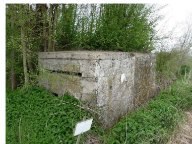
Vue générale, vers le nord-ouest. A noter la cellule d'éclatement constituant le couverture et deux petites ouvertures, sur l'élévation est, servant peut-être aux communications avec la tour d'observation située à Beaucamps-Ligny Phot. Jean-Marc Ramette IVR31_20155906040NUCA
