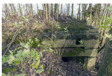
Vue latérale, vers l'est. Ouverture biaise surmontée de la cellule d'éclatement Phot. Pierre Thibaut IVR31_20155902039NUCA
