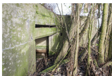
Elévation sud-est. L'entrée de la chambre de tir et le double couverture avec sa cellule d'éclatement Phot. Pierre Thibaut IVR31_20155902042NUCA
