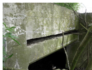
Elévation sud-est. Détail de la cellule d'éclatement Phot. Jean-Marc Ramette IVR31_20155906039NUCA
