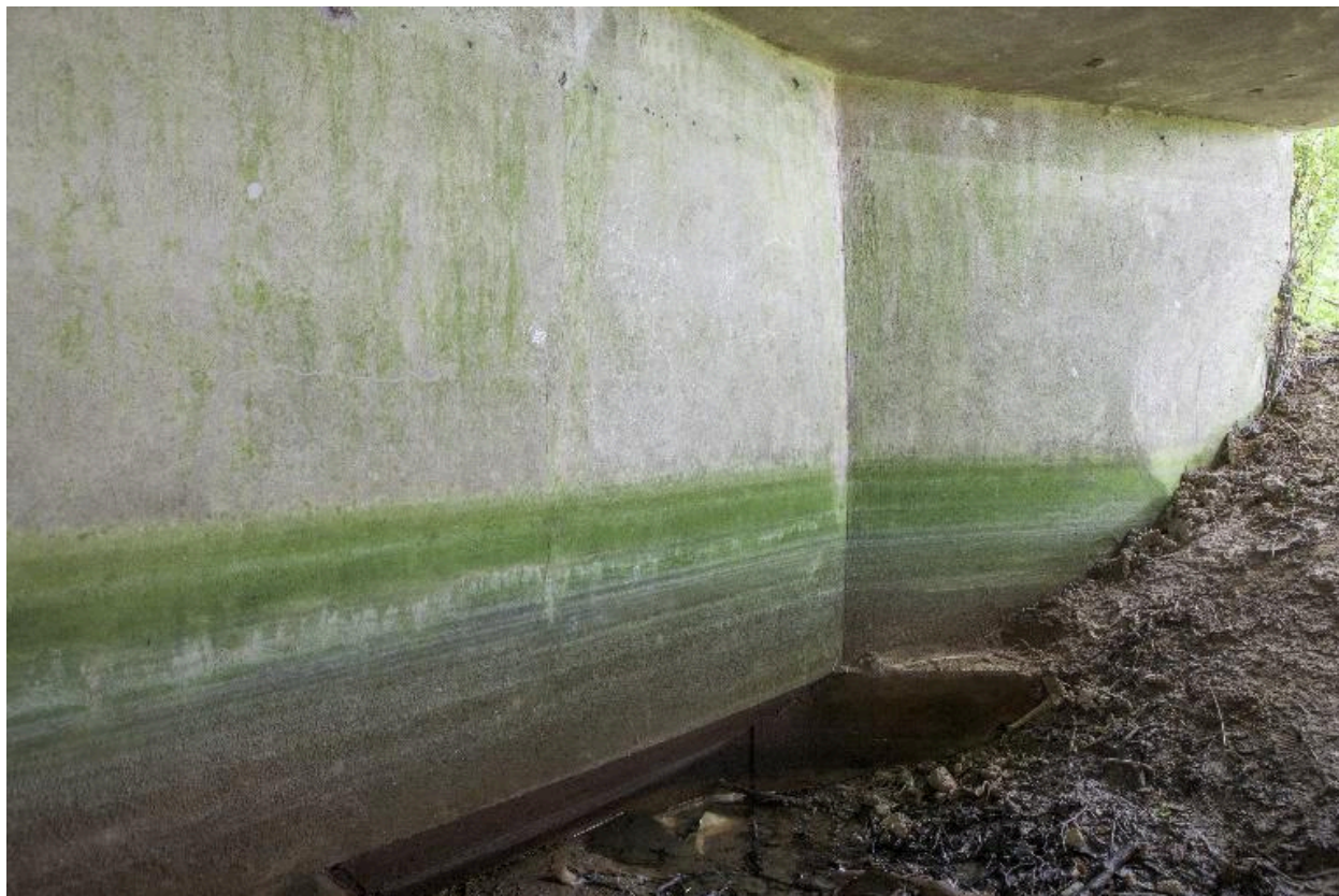
Chambre de tir. vers l'ouest.
