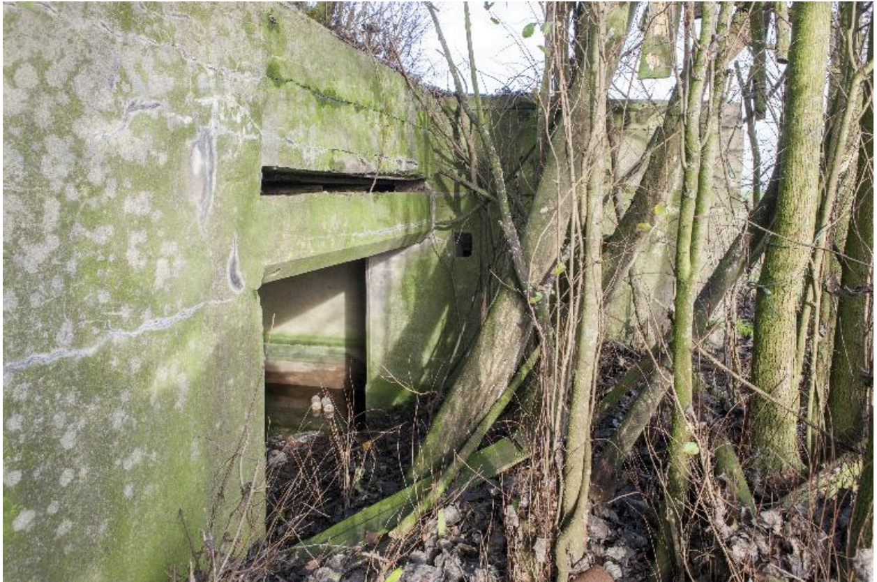
Elévation sud-est. L'entrée de la chambre de tir et le double couverture avec sa cellule d'éclatement
