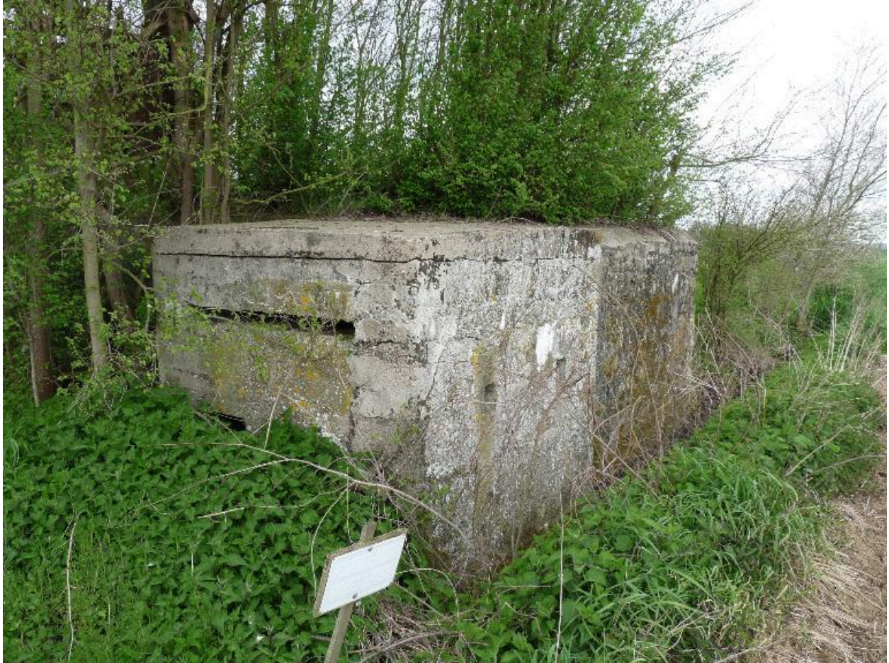
Vue générale, vers le nord-ouest. A noter la cellule d'éclatement constituant le couverture et deux petites ouvertures, sur l'élévation est, servant peut-être aux communications avec la tour d'observation située à Beaucamps-Ligny
