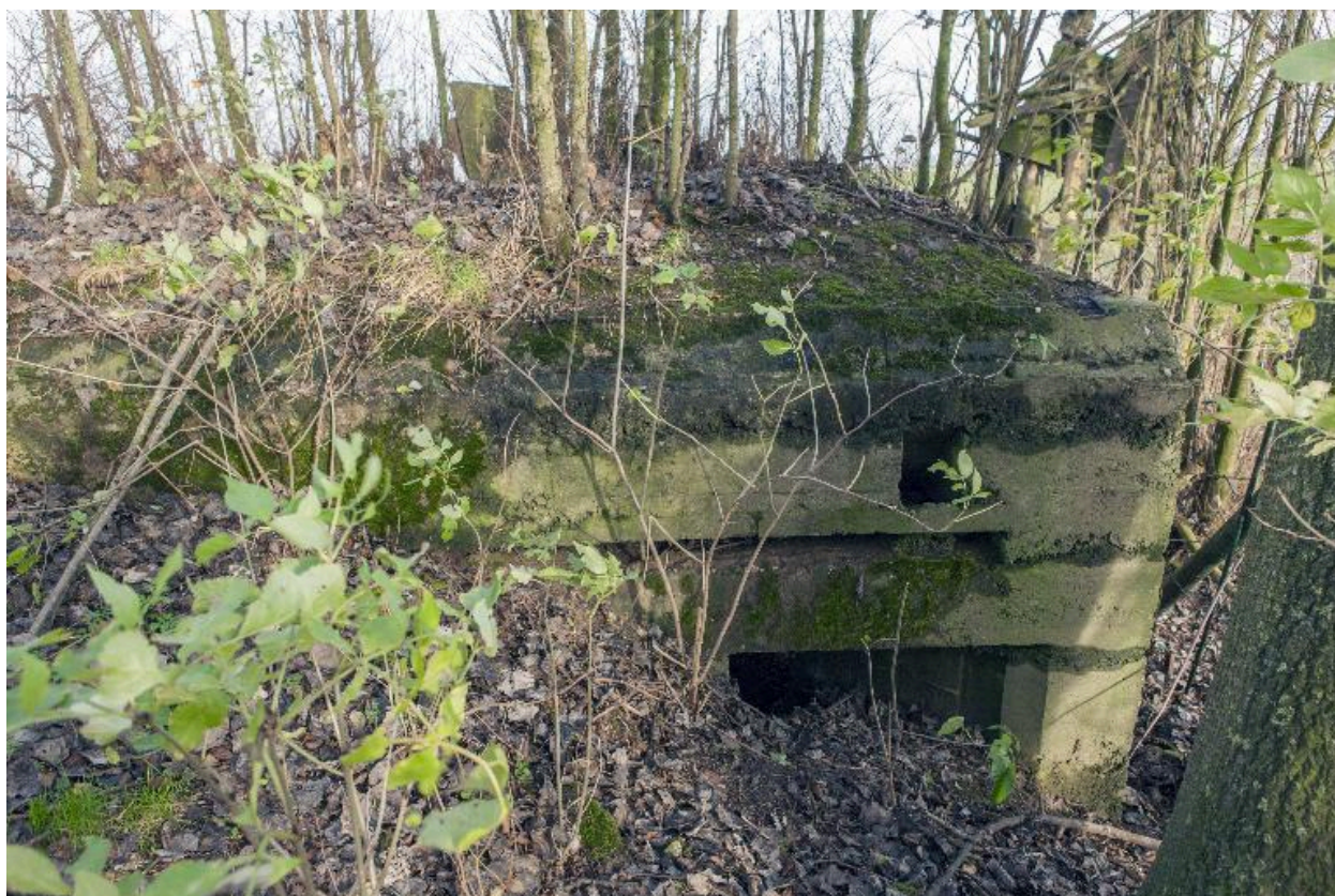
Vue latérale, vers l'est. Ouverture biaisée surmontée de la cellule d'éclatement
