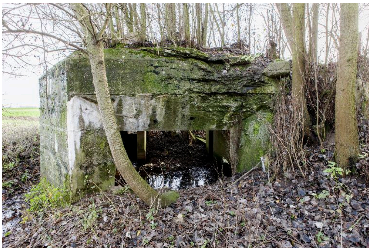
Vue vers sud. Sortie de la chambre de tir
