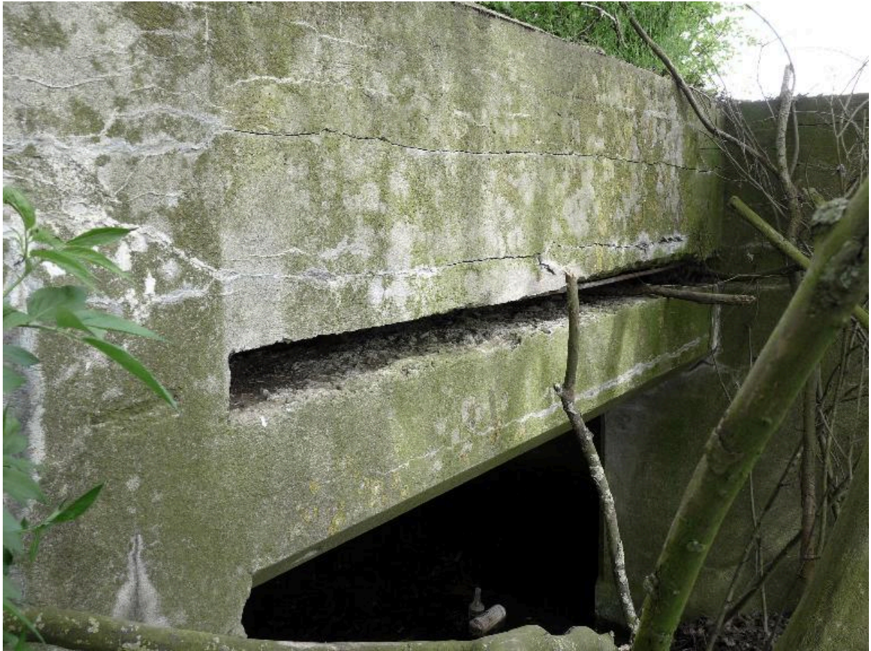
Elévation sud-est. Détail de la cellule d'éclatement
