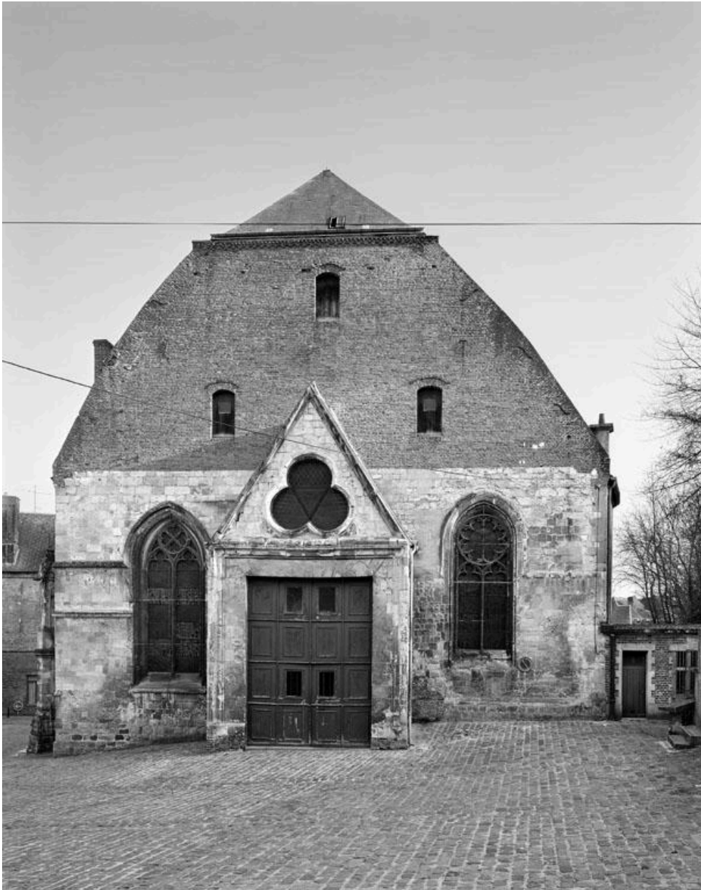
Vue de la façade occidentale.
