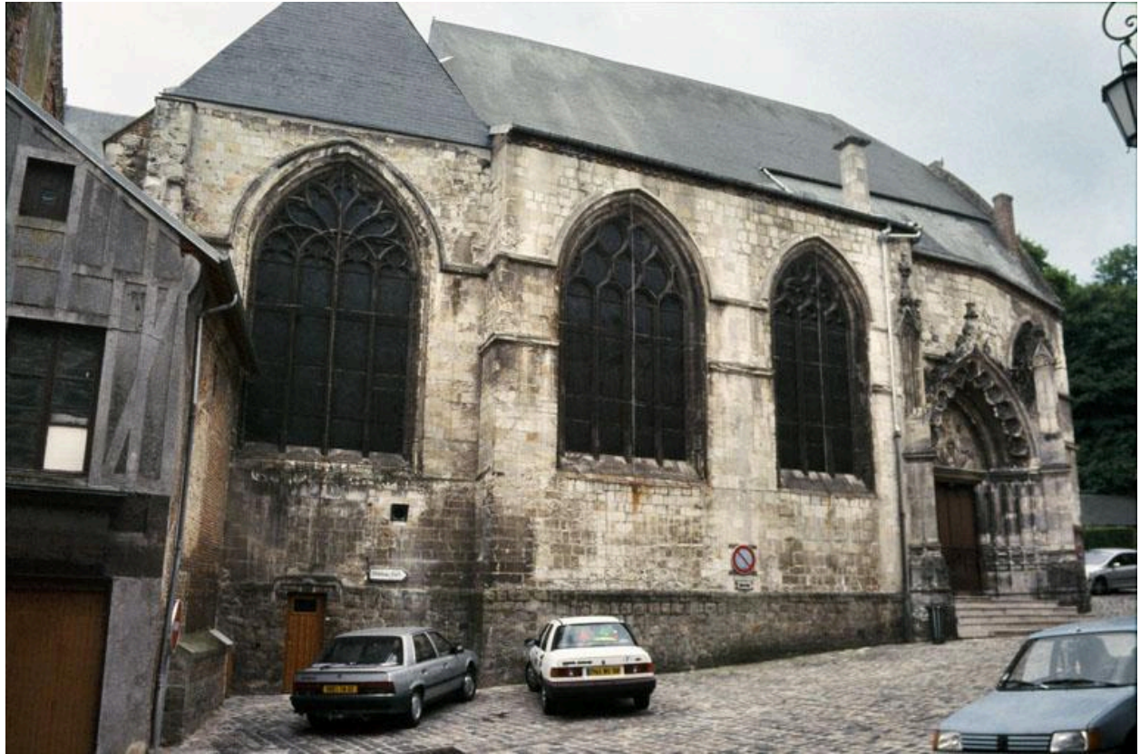
Vue du flanc nord.
