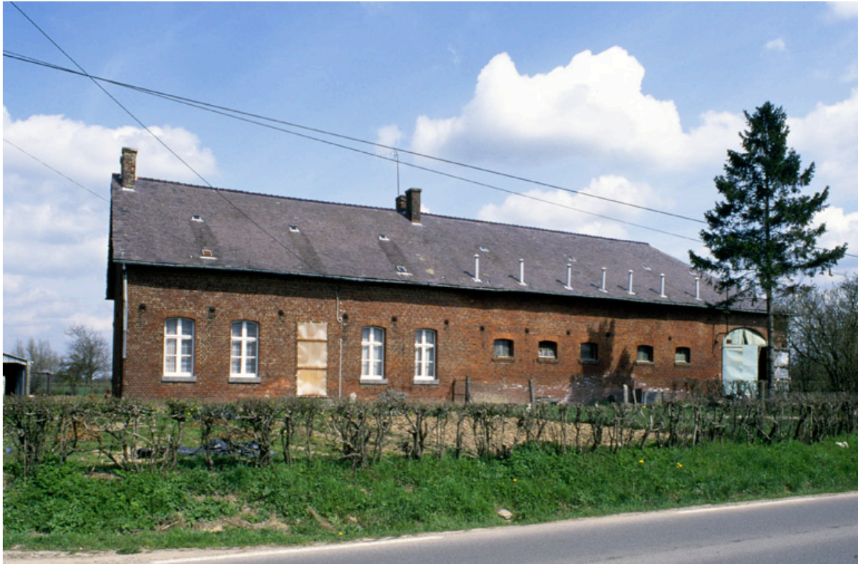
Vue de la ferme est.
