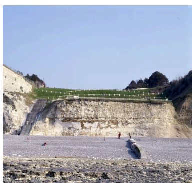
Détail de l'entaille dans la falaise. Phot. Marie-Laure Monnehay-Vulliet IVR22_20058000958XA
