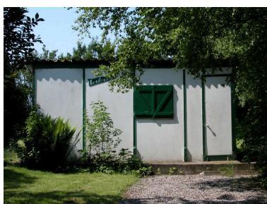
Cabanon Les Avelines, 28 route de la Falaise (1983 AM 275). Phot. Elisabeth Justome IVR22_20058003319NUCA
