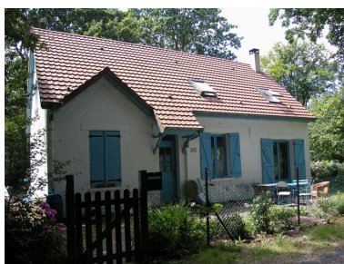
La Voix des Chênes, 2 route de la Mare aux Biches (1990 AL 46), reconstruite en 1951. Phot. Elisabeth Justome IVR22_20058003337NUCA
