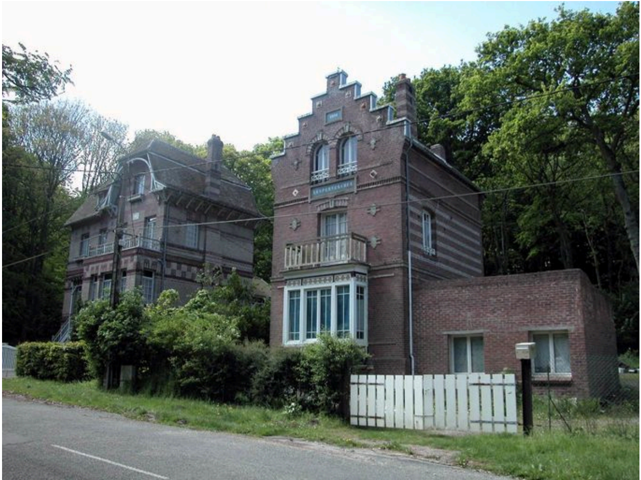
Villas le long de l'avenue principale menant à la plage (Les Noisettes et Les Pervenches).
