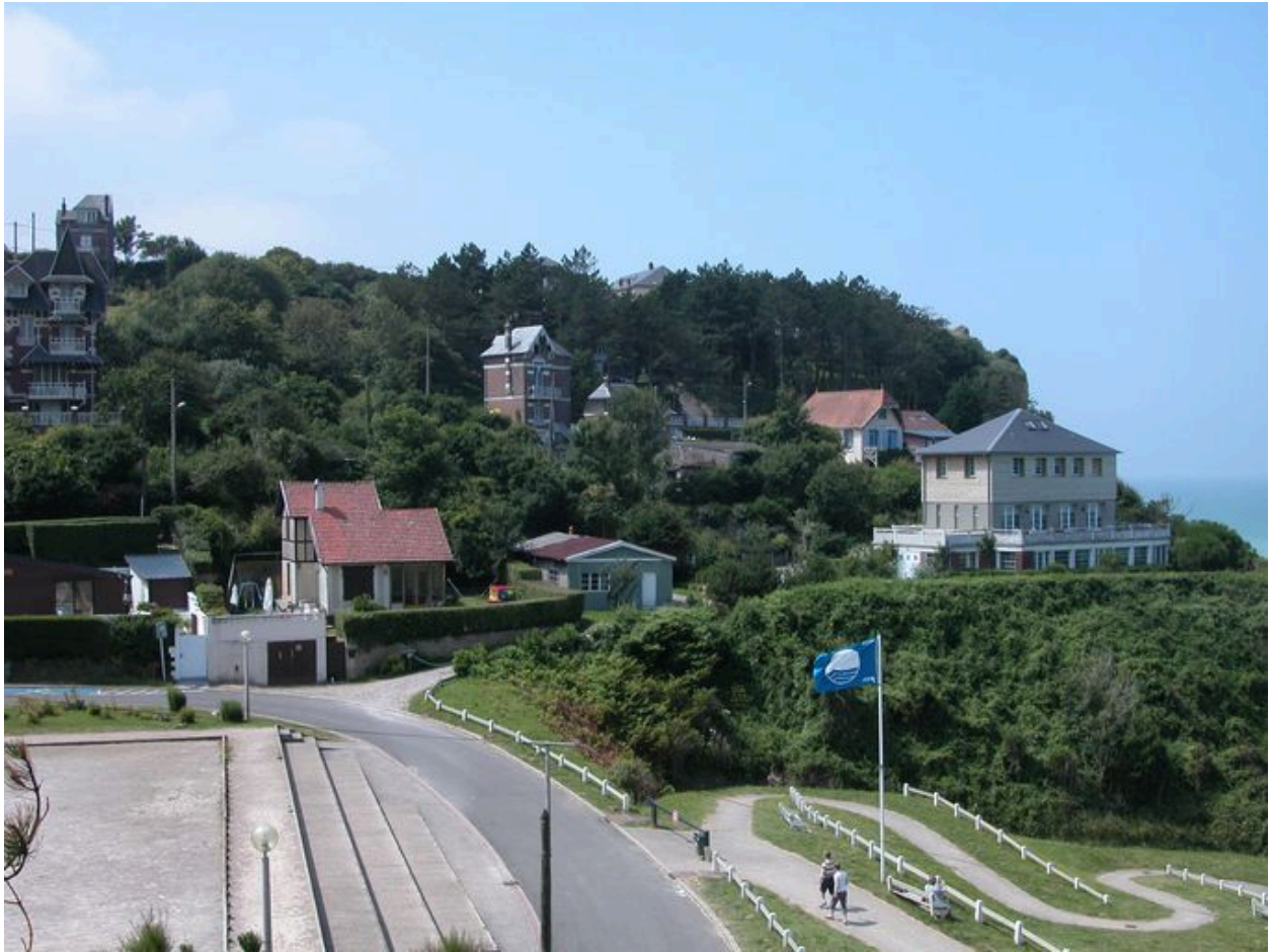
Les villas du coteau au sud du square, vue d'ensemble.
