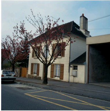
Vue générale depuis la rue. Phot. Thierry Lefébure IVR22_19940200411XA
