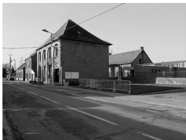
Vue générale de trois quarts, élévation antérieure. Phot. Philippe Dapvril IVR31_20055900160X
