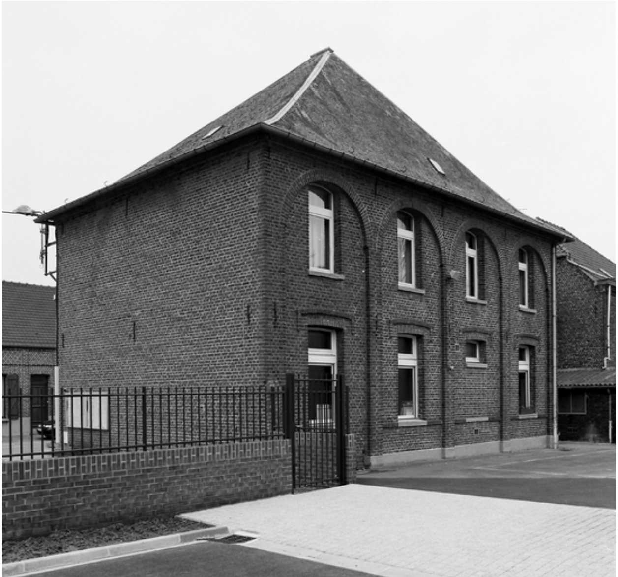
Elévation postérieure de trois quarts.
