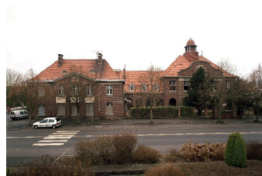
Vue générale de la façade, avenue Danicourt.
