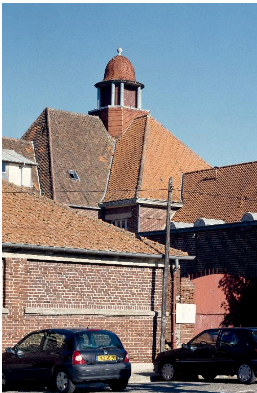
Vue partielle de la façade, rue Victor-Hugo.
