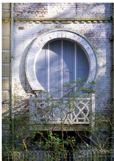
Détail d'une baie de la façade postérieure, devancée par un balcon en bois. Phot. Marie-Laure Monnehay-Vulliet IVR22_20058000145XA
