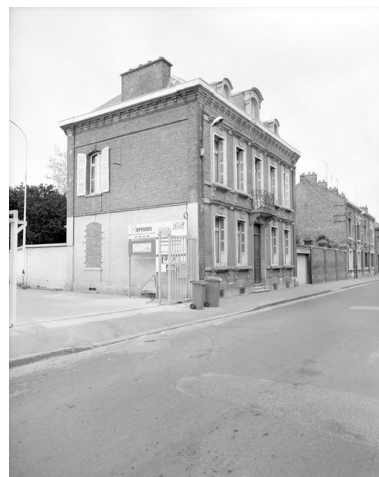
Logement patronal. Phot. Thierry Lefébure IVR22_19908001581X
