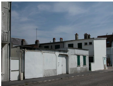
Élévation postérieure et garages, depuis la rue Dujardin.
