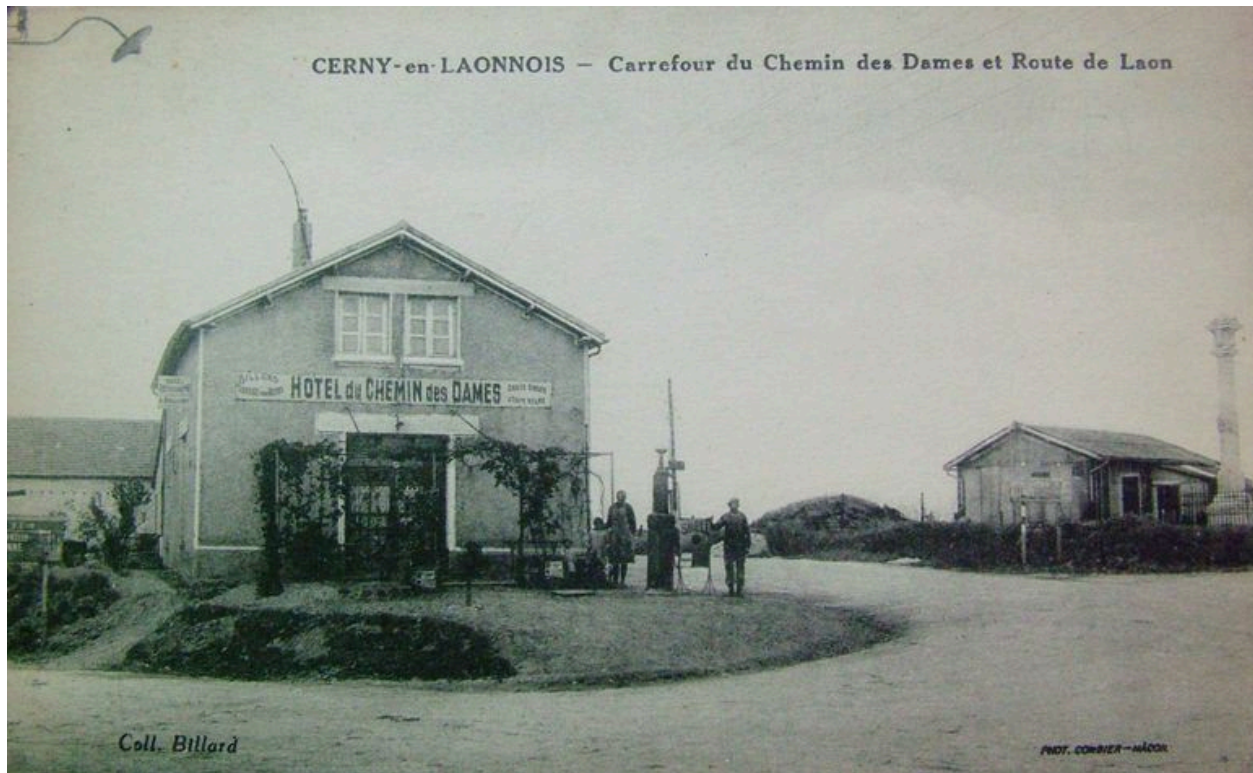
Vue de Cerny pendant sa reconstruction (coll. part).
