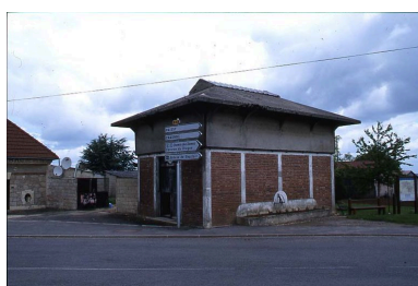
Vue d'un bâtiment communal servant à peser de lourdes charges. Phot. Inès Guérin IVR22_20030203179NUCA
