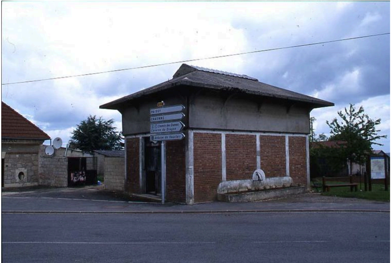
Vue d'un bâtiment communal servant à peser de lourdes charges.
