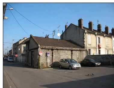
Vue générale de l'emprise de l'atelier et de la dernière travée existante. Phot. Clarisse Lorieux IVR22_20096005047NUCA
