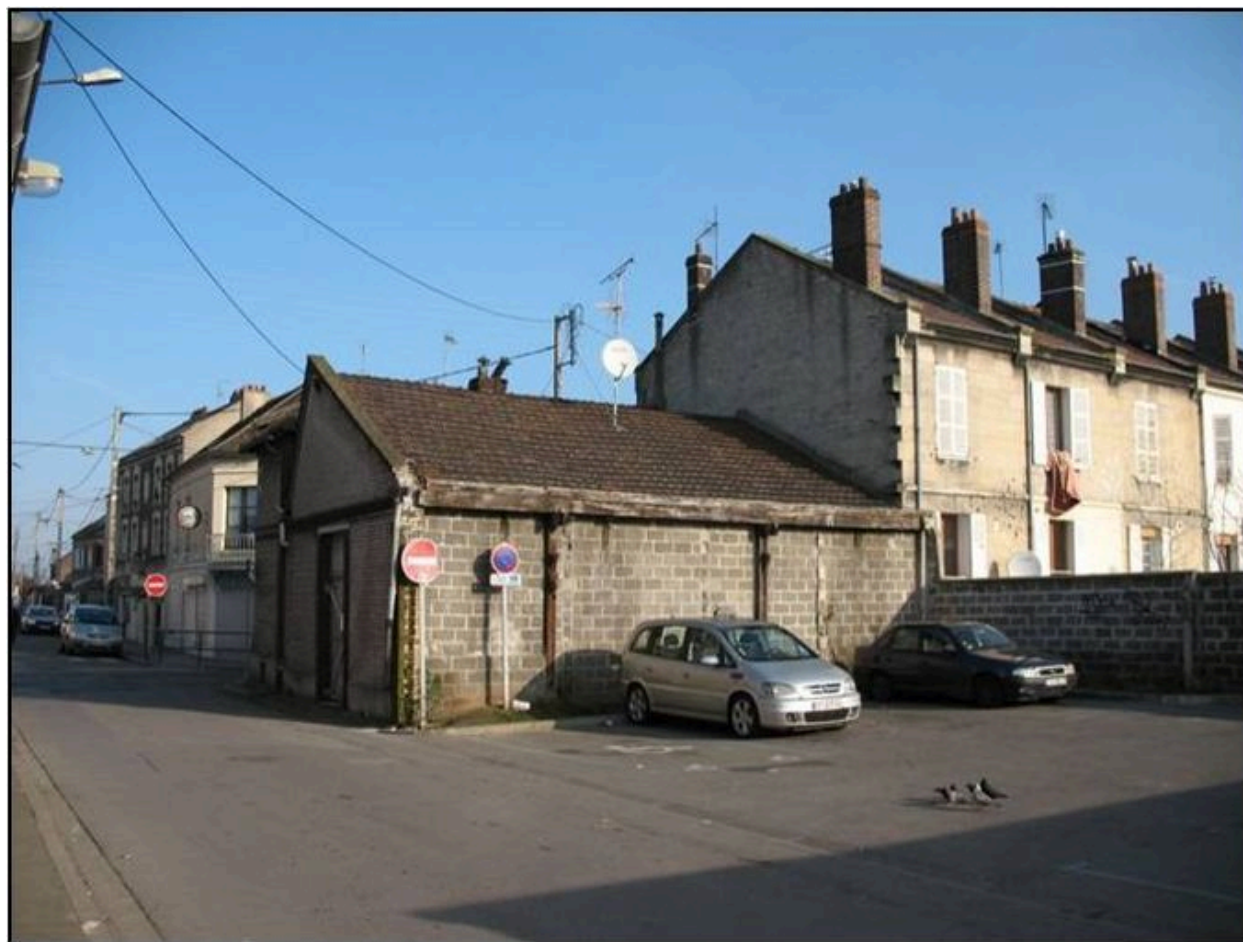
Vue générale de l'emprise de l'atelier et de la dernière travée existante.
