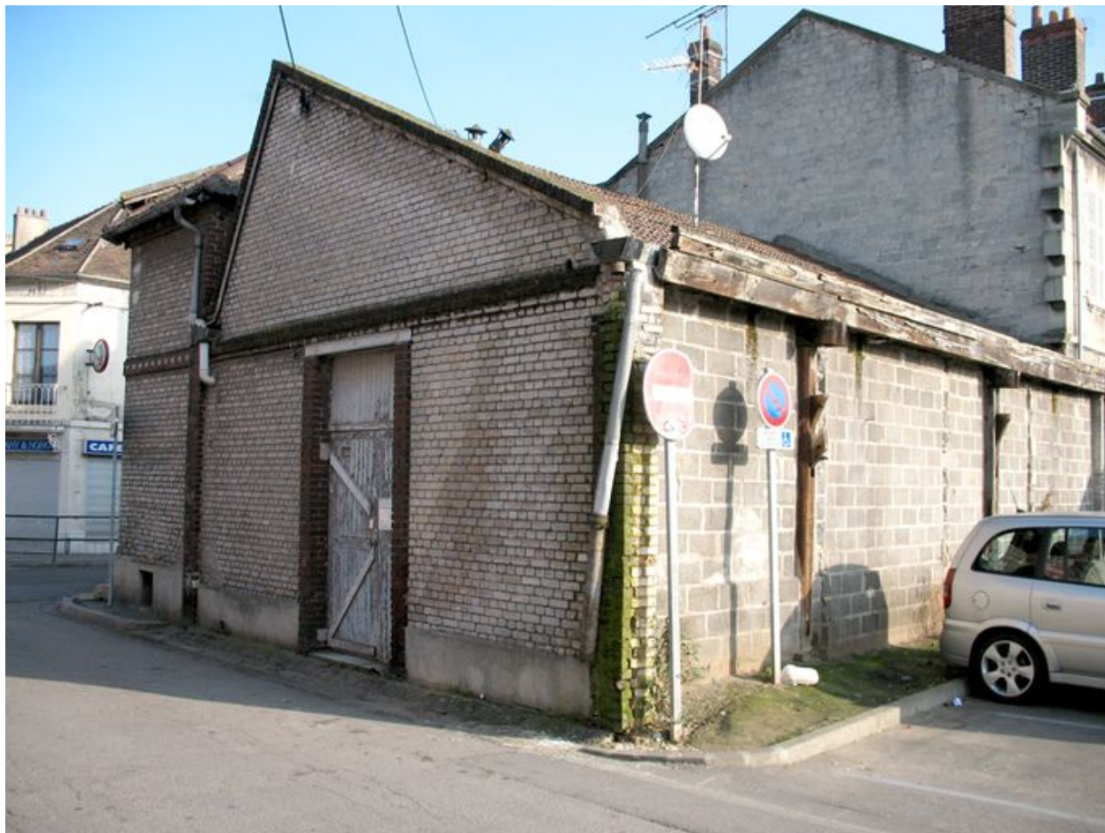
Vestige d'une travée en shed de l'atelier de menuiserie.
