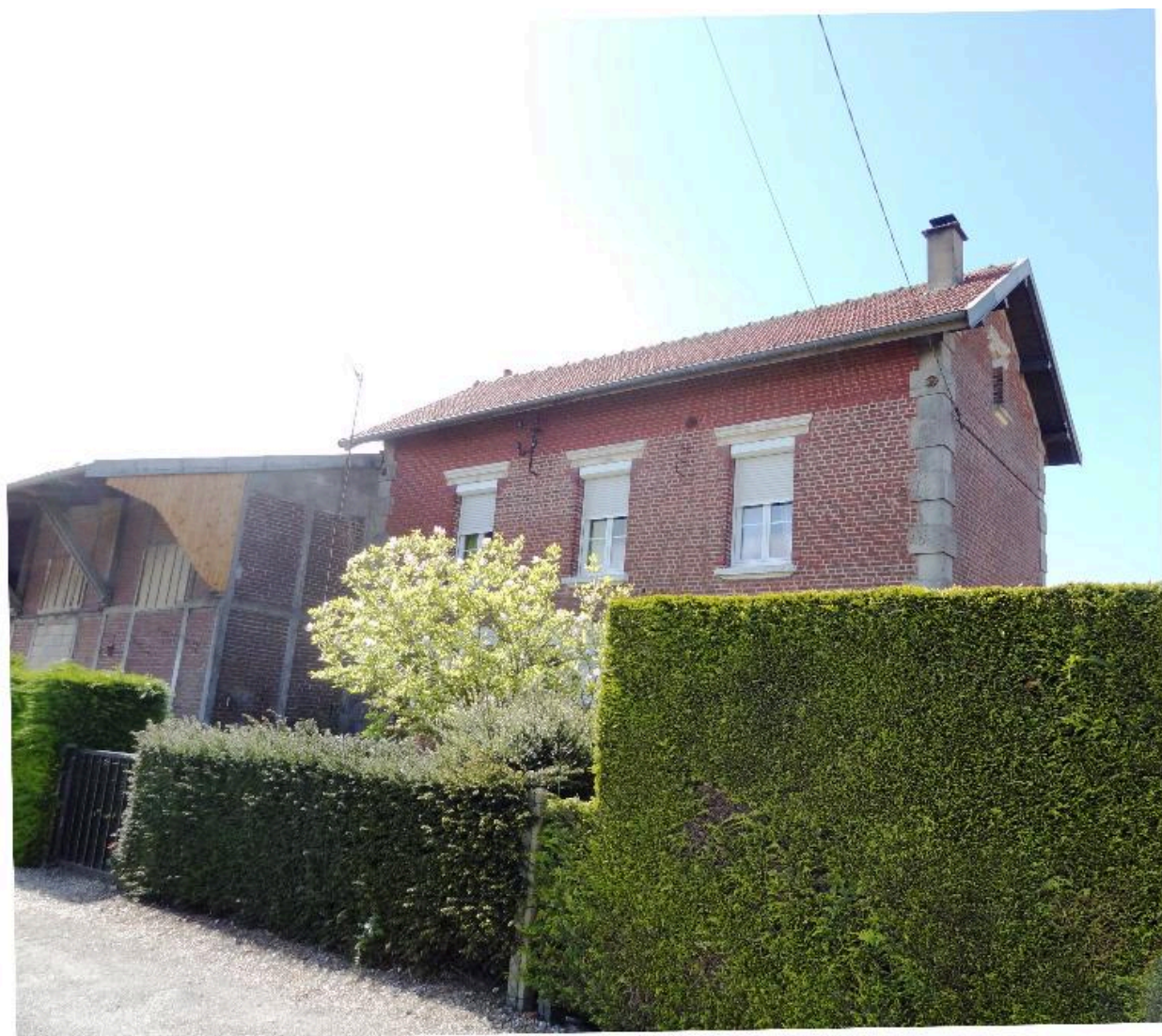
Vue générale gare de Saint-Quentin-la-Motte-Croix-au-Bailly.
