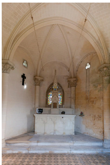
Vue intérieure de la chapelle funéraire de la famille Decourt-Roisin.
