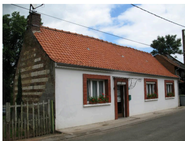
Maison 8 bis, rue de l'Eglise, avec pignon à assises alternées du début du 19 e siècle. Phot. Frédéric Fournis IVR22_20108010138NUCA
