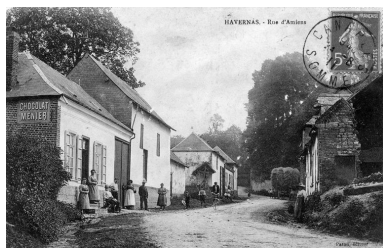
Rue d'Amiens, avant 1911 (coll. part.). Phot. Monnehay-Vulliet Marie-Laure IVR22_20108000385NUCA
