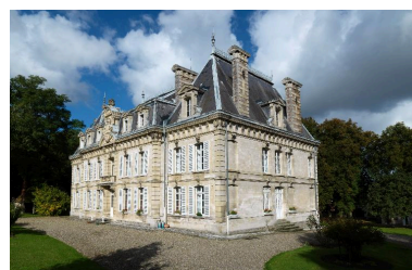
Le château d'Havernas. Phot. Marie-Laure Monnehay-Vulliet IVR22_20128000894NUC2A
