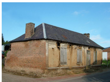
Ancienne maison en torchis, rue de l'Eglise, 1 ère moitié du 19 e siècle. Phot. Frédéric Fournis IVR22_20108001325NUCA
