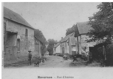
Rue d'Amiens, avant 1914 (coll. part.). Phot. Monnehay-Vulliet Marie-Laure IVR22_20108000386NUCA
