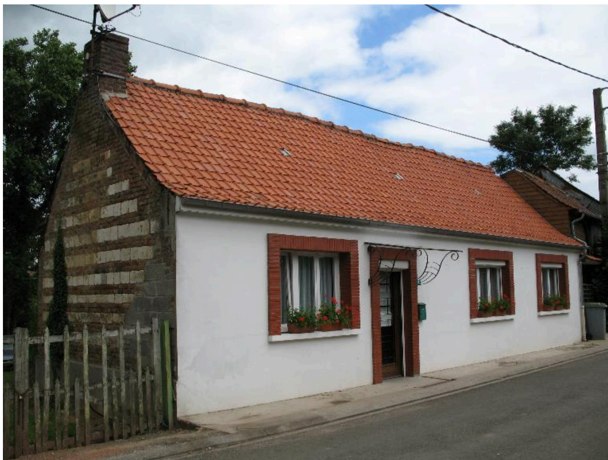
Maison 8 bis, rue de l'Eglise, avec pignon à assises alternées du début du 19e siècle.
