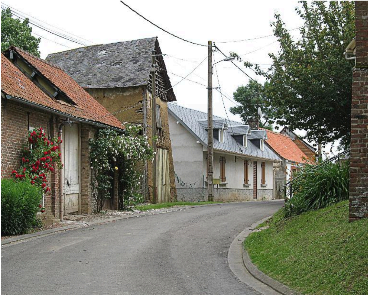
Vue partielle de la rue de l'Eglise.
