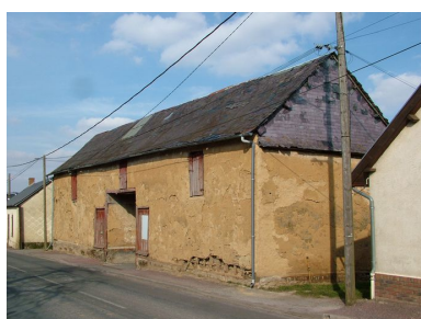
Grange en torchis de l'ancienne ferme, 5 rue d'Amiens, 19 e siècle. Phot. Frédéric Fournis IVR22_20108001120NUCA
