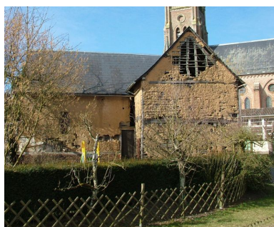
Bâtiments en torchis à l'arrière de l'ancien café, 2 place de l'Eglise, 19 e siècle. Phot. Frédéric Fournis IVR22_20108001096NUCA
