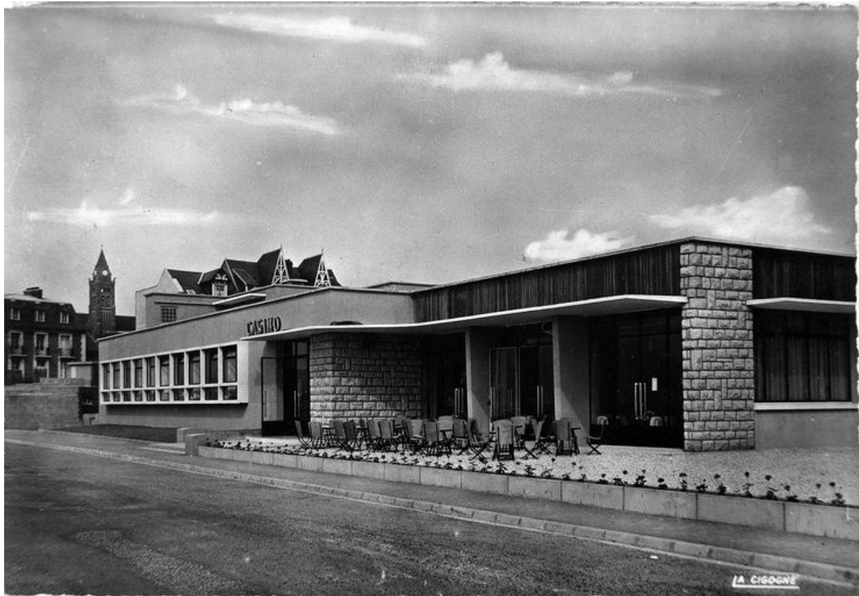
Le sixième casino avant les transformations en façade sur mer, carte postale, 3e quart 20e siècle (coll. part.).
