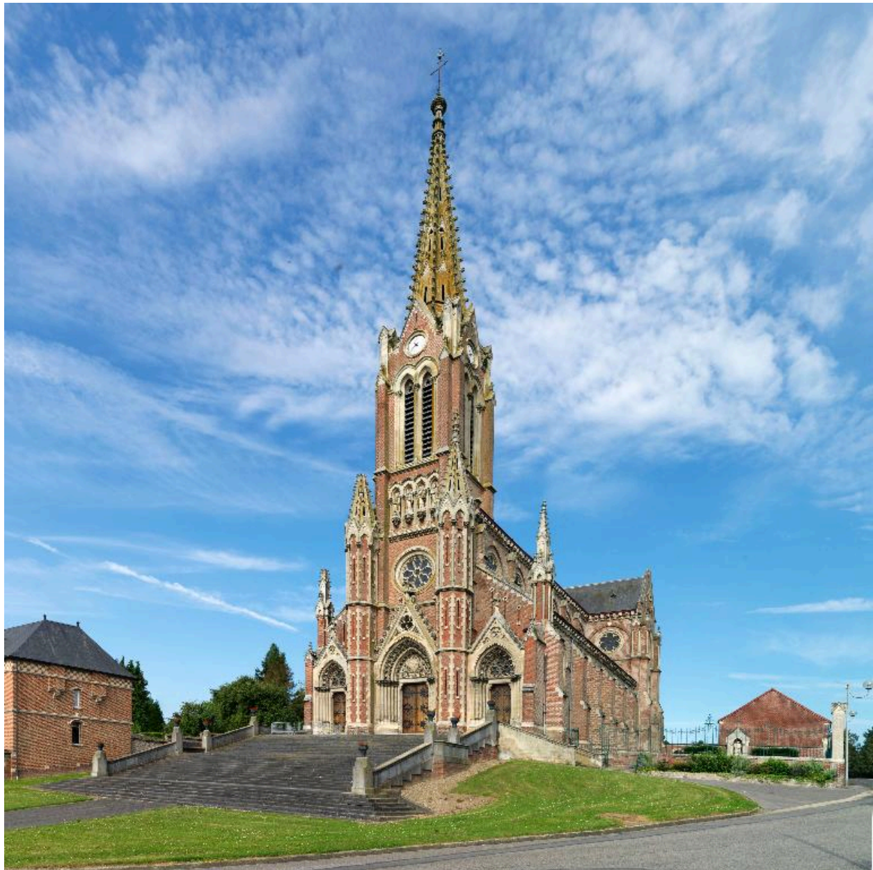
Vue d'ensemble extérieur sud ouest.
