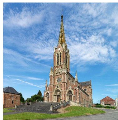
Vue d'ensemble extérieur sud ouest.
