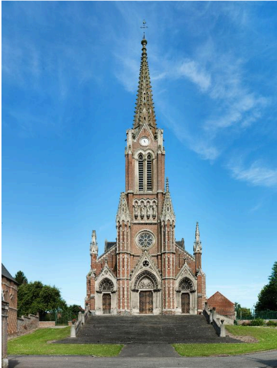
Vue d'ensemble occidentale, de face.
