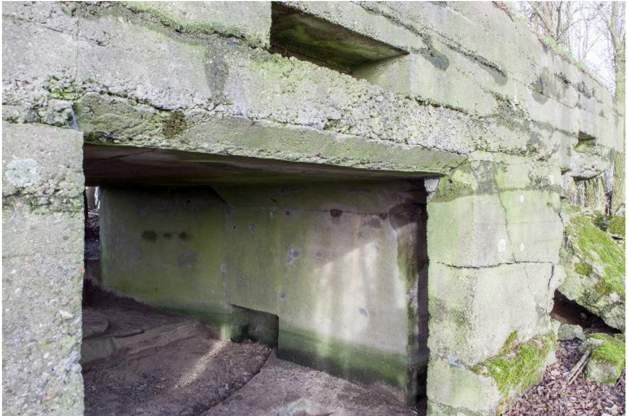
Elévation sud, détail de la cellule d'éclatement
