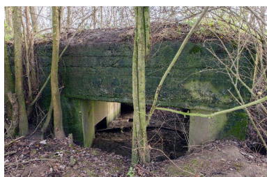
Elévation nord, la chambre de tir Phot. Pierre Thibaut IVR31_20155902036NUCA
