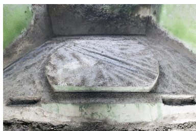
Chambre de tir, vers la sortie : plate-forme d'artillerie Phot. Pierre Thibaut IVR31_20155902030NUCA
