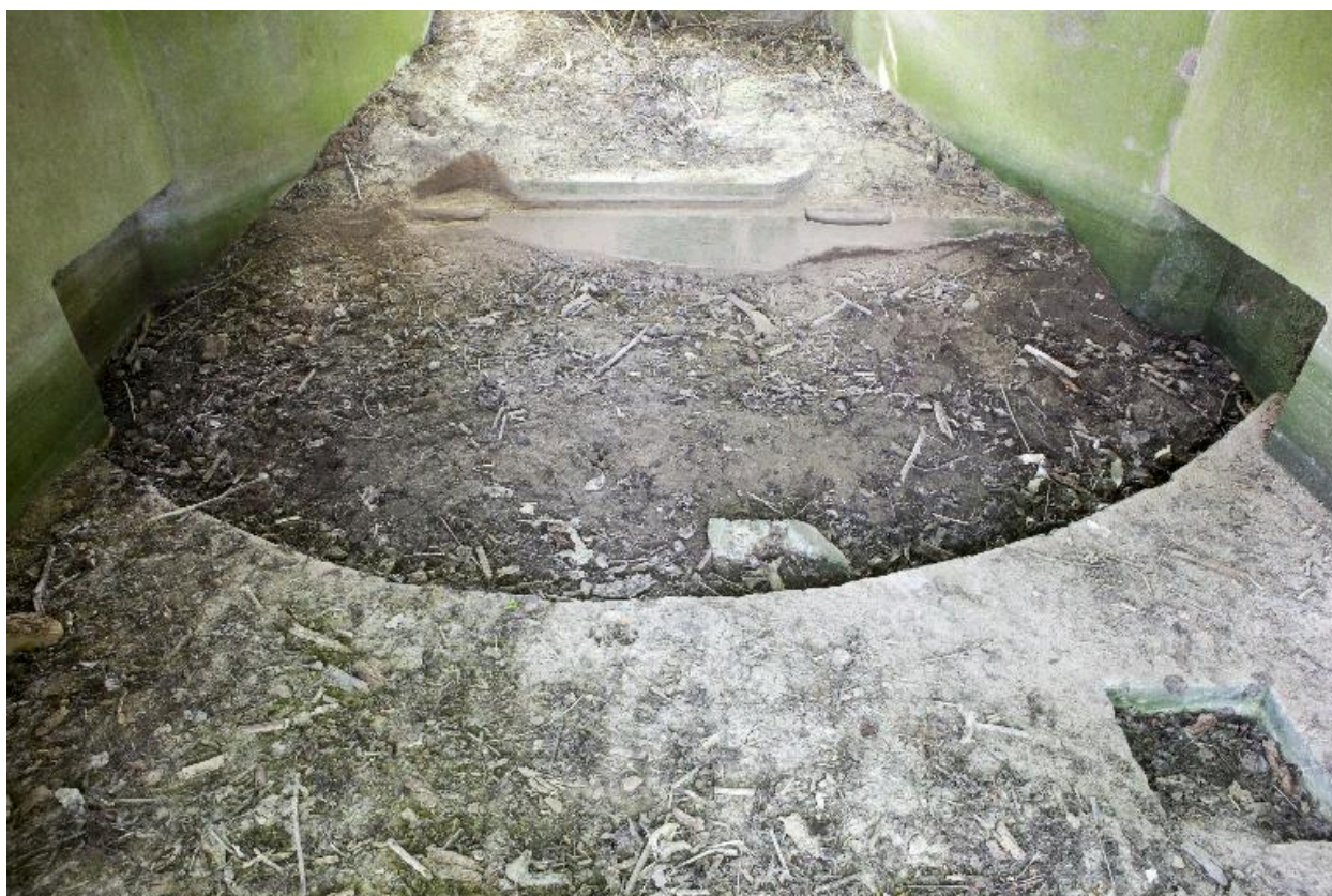
Chambre de tir, vers la sortie : Plate-forme d'artillerie
