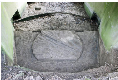
Depuis la sortie de la chambre de tir, plate-forme d'artillerie Phot. Pierre Thibaut IVR31_20155902034NUCA
