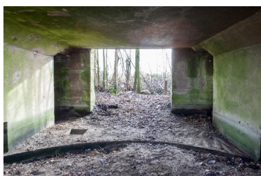
La chambre de tir avant déblaiement, vers le sud Phot. Pierre Thibaut IVR31_20155902033NUCA
