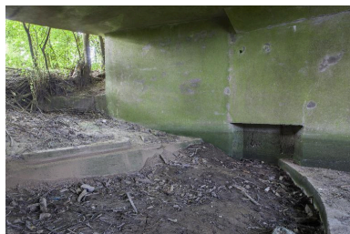
Vue intérieure de la chambre de tir, vers le nord. Phot. Pierre Thibaut IVR31_20155901348NUCA
