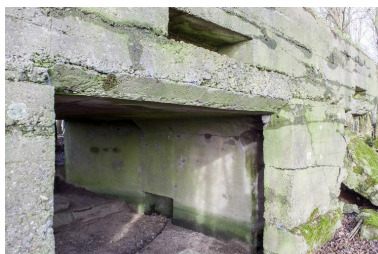
Elévation sud, détail de la cellule d'éclatement Phot. Pierre Thibaut IVR31_20155902038NUCA
