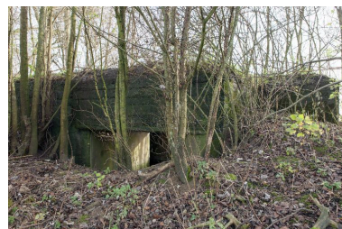
Elévation nord Phot. Pierre Thibaut IVR31_20155902035NUCA
