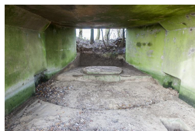
La chambre de tir avant déblaiement, vers le nord Phot. Pierre Thibaut IVR31_20155902032NUCA
