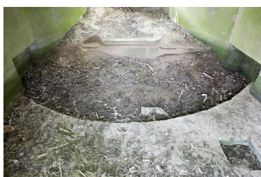
Chambre de tir, vers la sortie : Plate-forme d'artillerie Phot. Pierre Thibaut IVR31_20155901350NUCA
