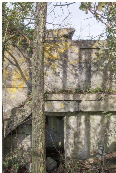
Elévation ouest, escalier, banquette de tir et cartouche Phot. Pierre Thibaut IVR31_20155901991NUCA
