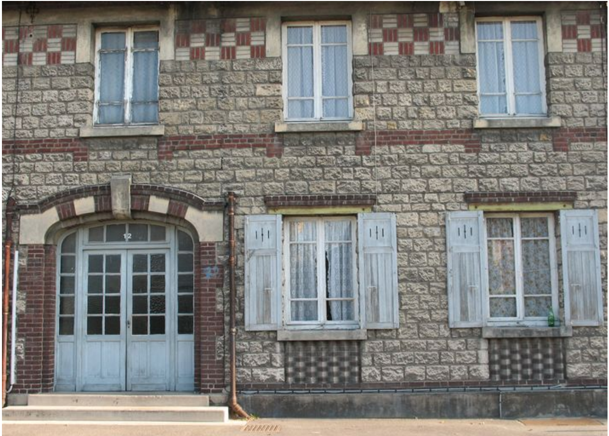
Détail de la façade sur rue.
