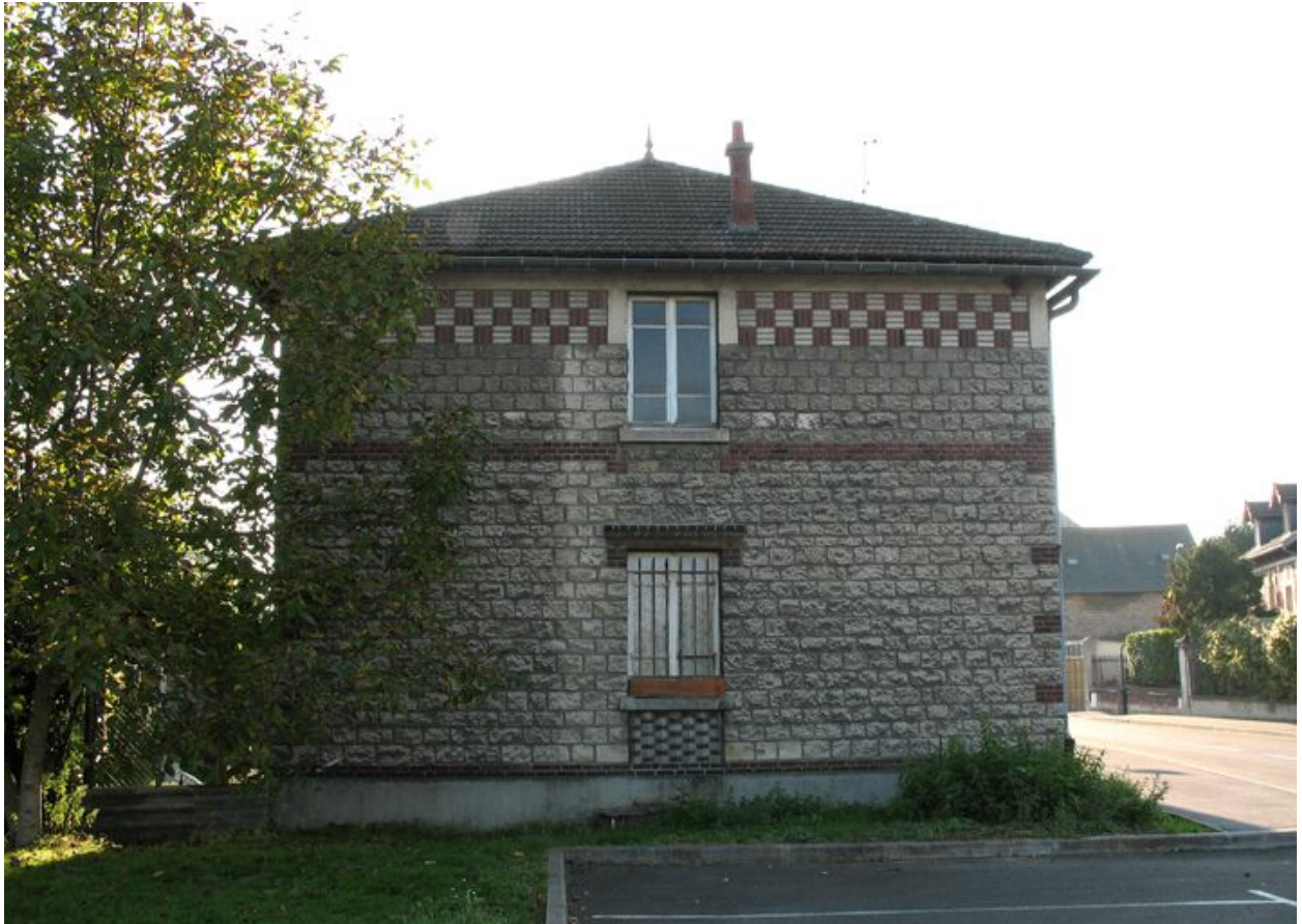
Mur pignon nord-est.
