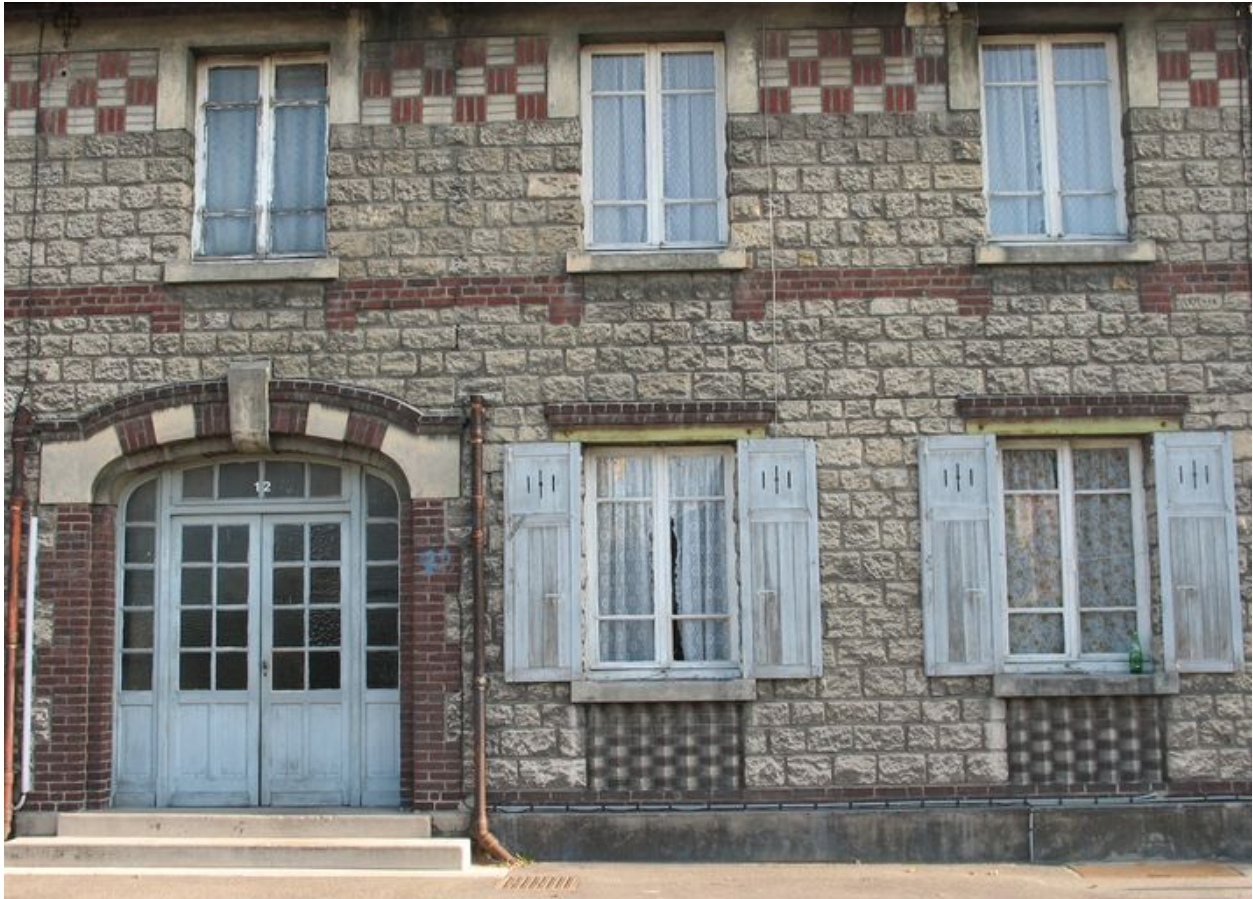
Détail de la façade sur rue.
