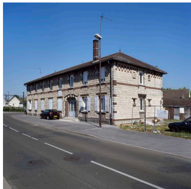
Logement d'ouvriers dit le pou qui pète. Phot. Thierry Lefébure IVR22_20106000657XA
