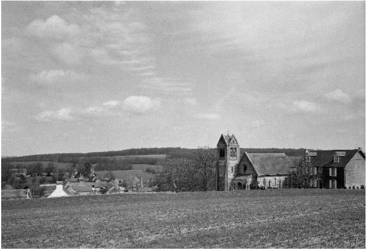
Vue de l'église et de son site, depuis le sud-ouest.
