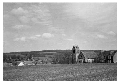
Vue de l'église et de son site, depuis le sud-ouest. Phot. Fabrice Charrondière IVR22_19860200312X
