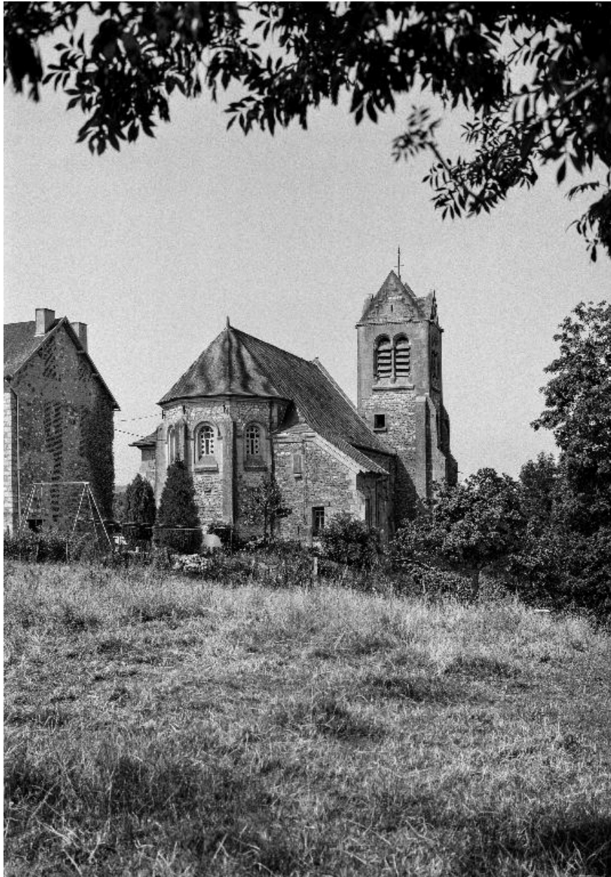
Vue d'ensemble de l'édifice depuis le nord-est.
