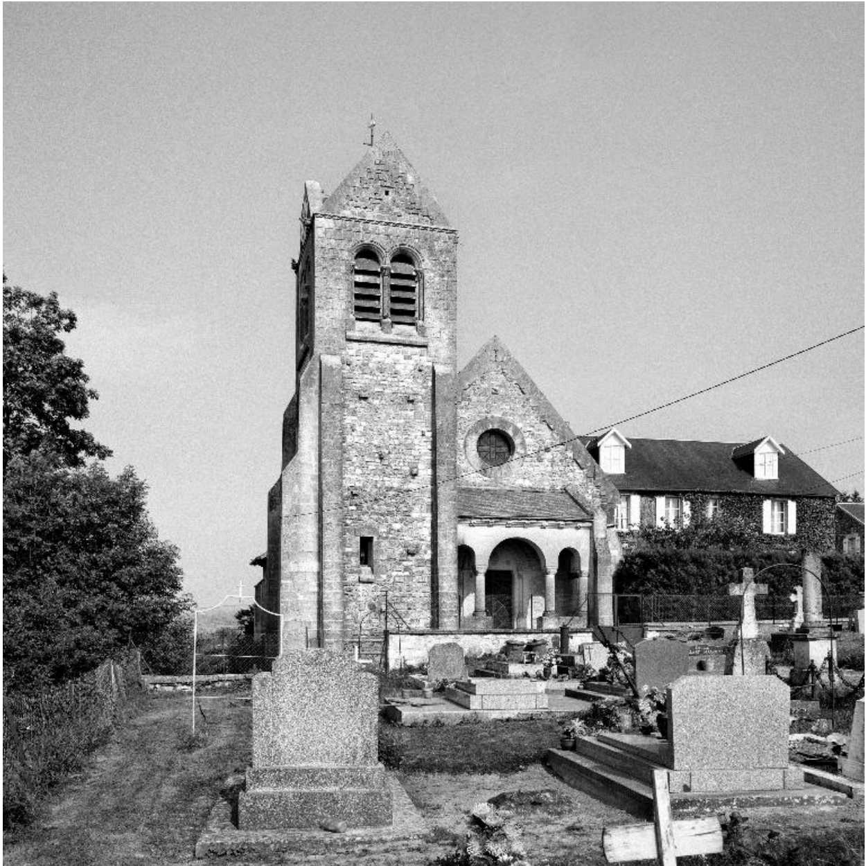
Vue de la façade de l'église, depuis le cimetière.
