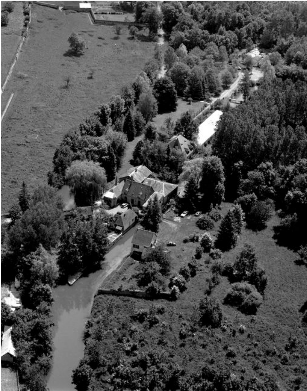
Vue aérienne de l'usine en 1994.
