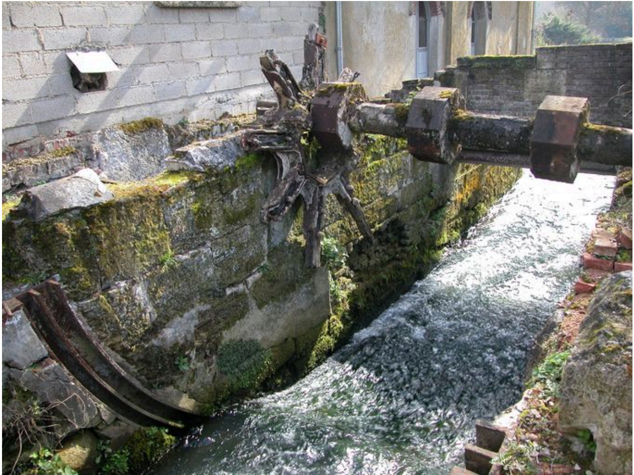
La coulerie du moulin avec les vestiges de la vanne plongeante incurvée et de la roue hydraulique.
