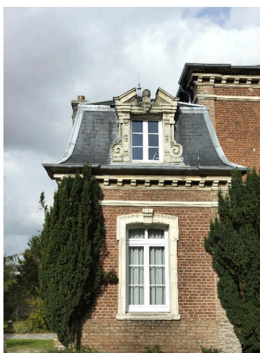
Détail de la lucarne. Phot. Thierry Lefébure IVR22_20148000634NUC2A
