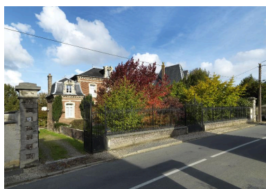
Vue de situation depuis la Grande Rue. Phot. Thierry Lefébure IVR22_20148000632NUC2AQ
