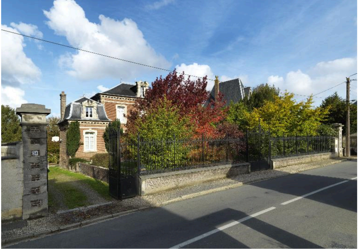
Vue de situation depuis la Grande Rue.
