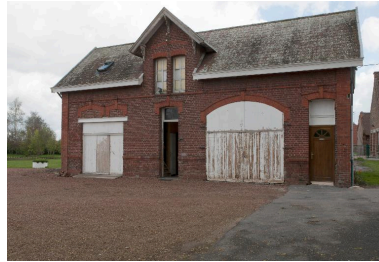
Dépendances (?) de l'ancienne maison devenue mairie.
