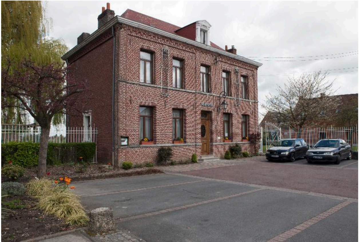
Vue générale de trois quarts de l'élévation principale.
