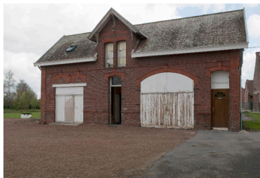
Dépendances (?) de l'ancienne maison devenue mairie.
