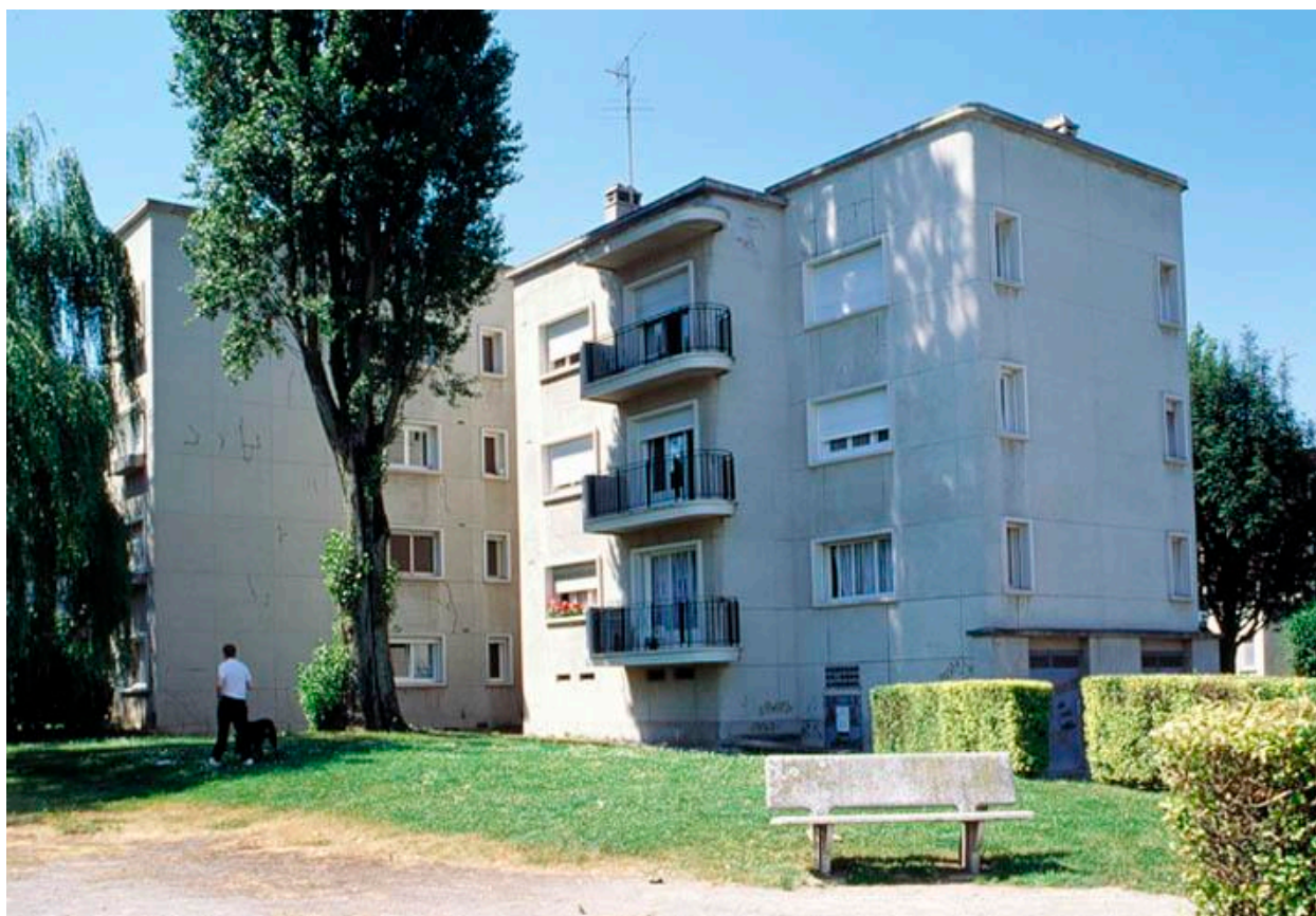
Élévation postérieure d'un immeuble.
