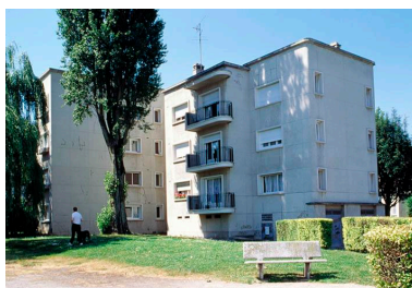
Élévation postérieure d'un immeuble.
