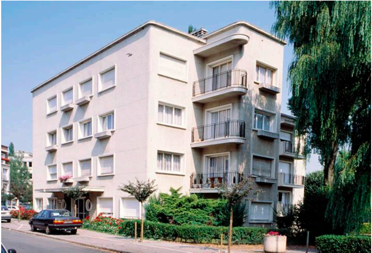
Vue générale de l'immeuble Gounod.
