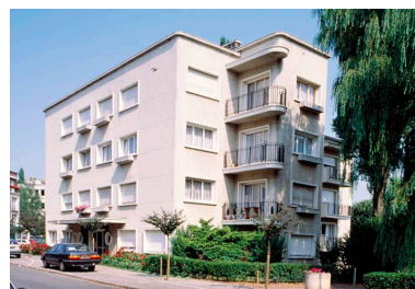
Vue générale de l'immeuble Gounod.
