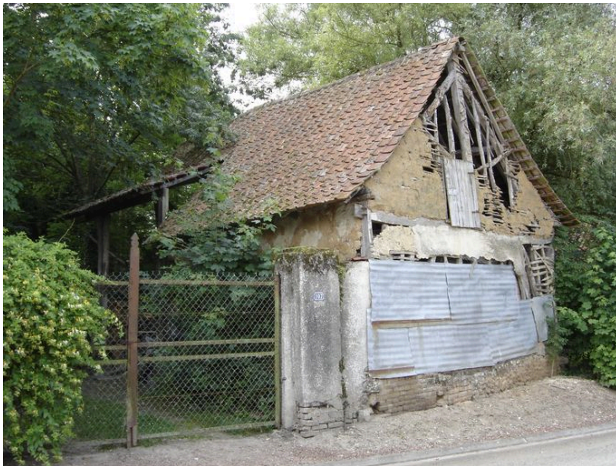
Vue générale de la charretterie.
