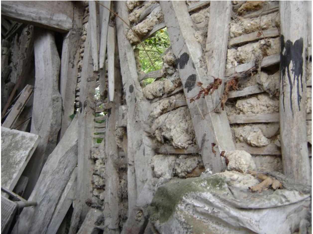
Vue intérieure d'un des deux murs gouttereaux.
