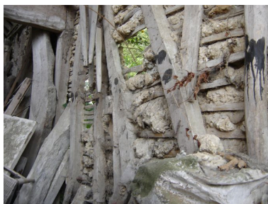
Vue intérieure d'un des deux murs gouttereaux. Phot. Inès Guérin IVR22_20058006205NUCA
