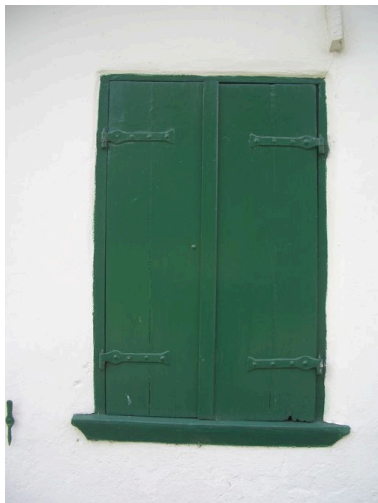
Détail du contrevent sur rue. Phot. Inès Guérin IVR22_20078005156NUCA
