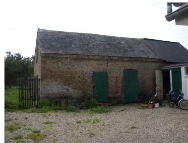
Vue des dépendances en fond de cour. Phot. Inès Guérin IVR22_20078005157NUCA
