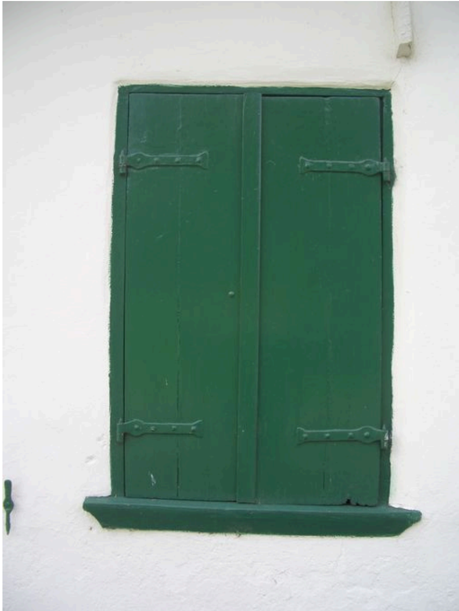
Détail du contrevent sur rue.
