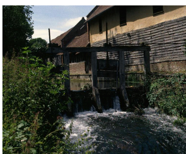
Vue du déversoir.
