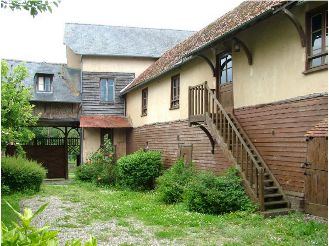
Vue des bâtiments depuis la cour.
