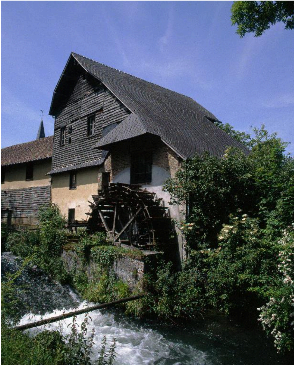
Vue du moulin, depuis le sud-est.
