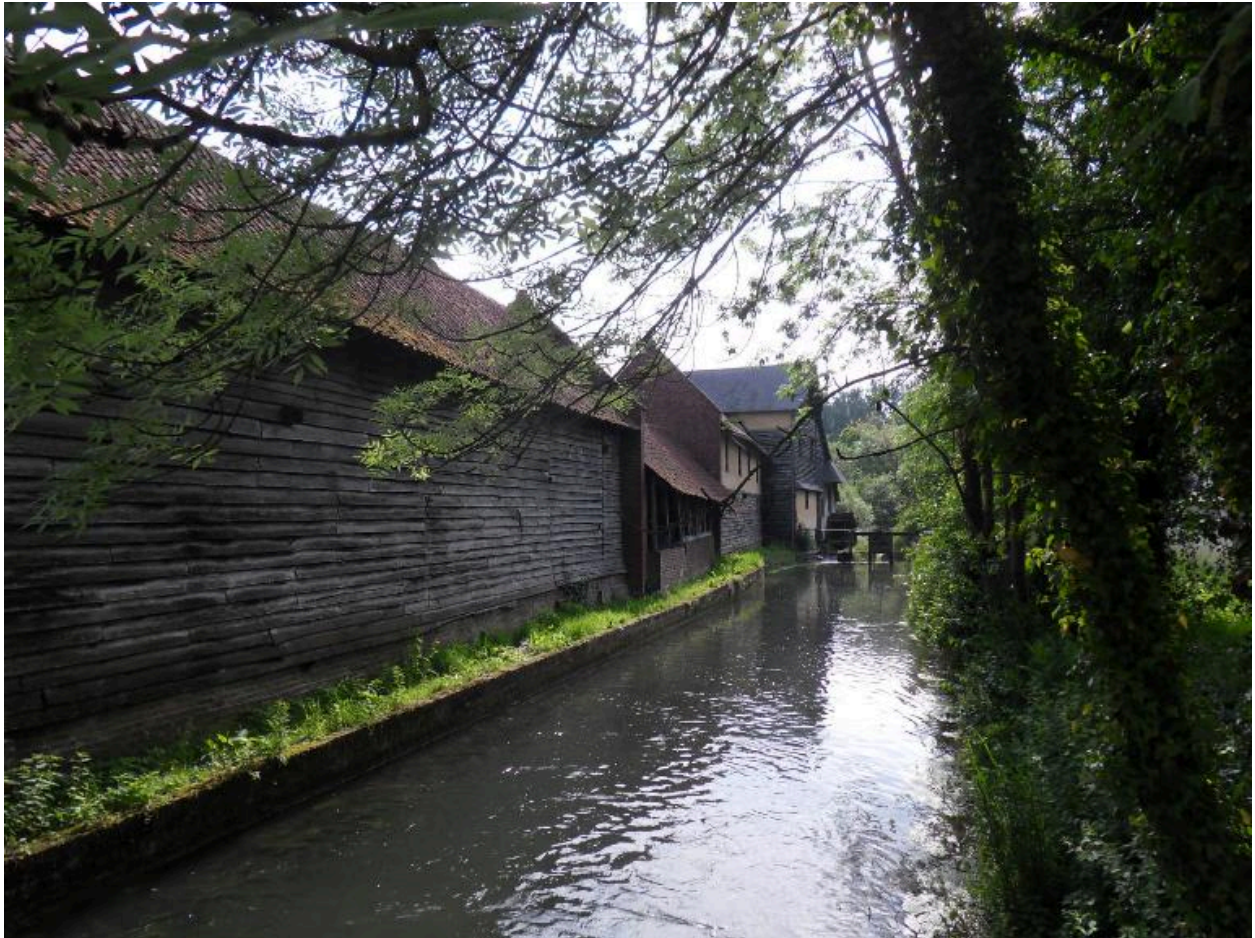
Vue de situation depuis le nord-ouest.
