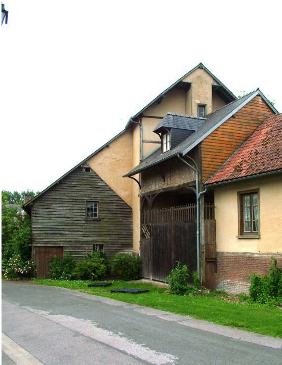
Vue depuis la rue du Moulin.
