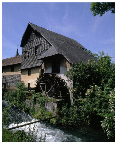
Vue du moulin, depuis le sud-est.
