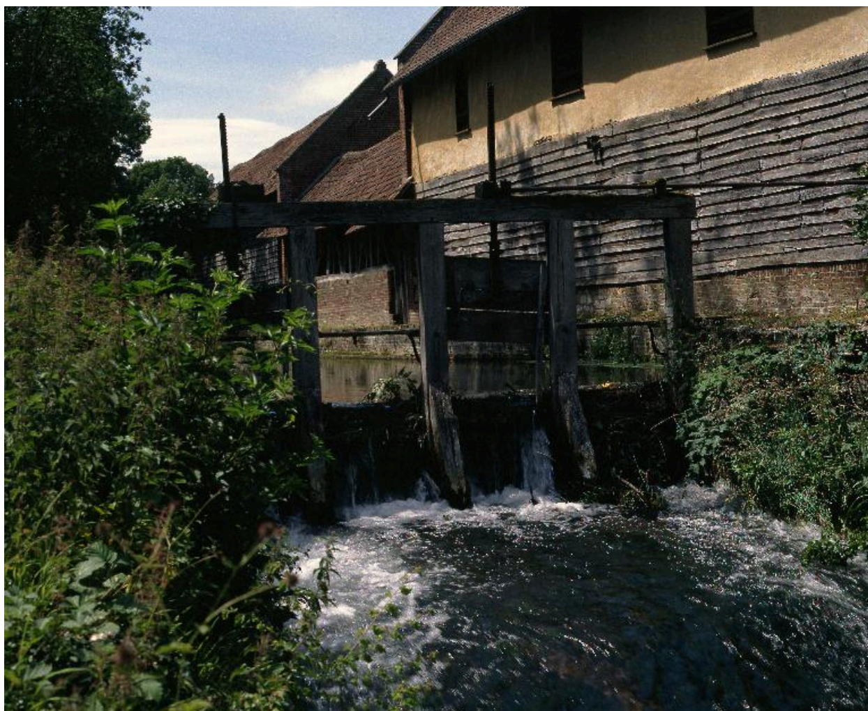
Vue du déversoir.
