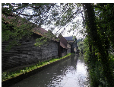
Vue de situation depuis le nord-ouest.
