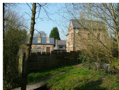
Vue arrière depuis la Nièvre. Phot. Frédéric Fournis IVR22_20098005078NUCA
