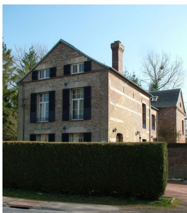
Vue du logement depuis la rue. Phot. Frédéric Fournis IVR22_20098005077NUCA
