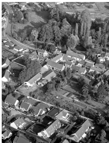
Vue aérienne de l'usine Selle en 1994. Phot. Sanson Aviation IVR22_19946001745X
