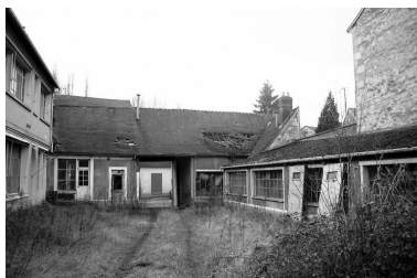
Vue d'ensemble sur cour. Phot. Bertrand Fournier IVR22_20006001778Z
