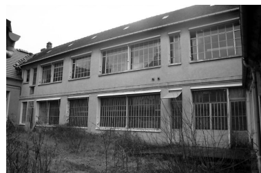
Les ateliers de fabrication, façade sur cour. Phot. Bertrand Fournier IVR22_20006001780Z
