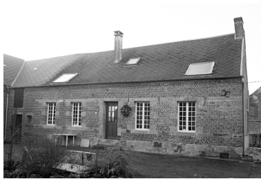
Elévation sur cour du logis et de l'étable attenante. Phot. Thierry Lefébure IVR22_19960200942X
