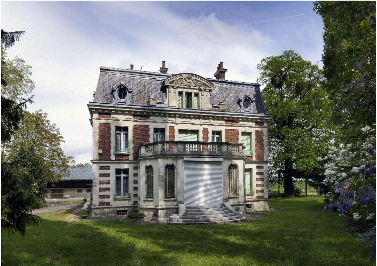
Vue de la façade du château.
