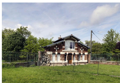
La maison de gardien à l'entrée latérale du château Maguin, façade sur cour. Phot. Thierry Lefébure IVR22_20160200108NUC2A
