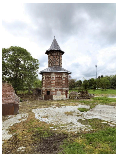
Le pigeonnier. Phot. Thierry Lefébure IVR22_20160200109NUC2A
