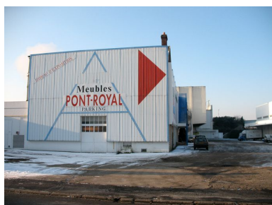
Cour de livraison et parking du magasin Pont-Royal situés 33 rue Carnot. Phot. Clarisse Lorieux IVR22_20096005121NUCA
