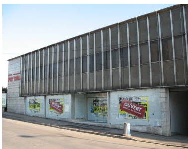
Détail de la structure verre et fer de la façade sur la rue Gambetta en février 2009. Phot. Clarisse Lorieux IVR22_20096005119NUCA
