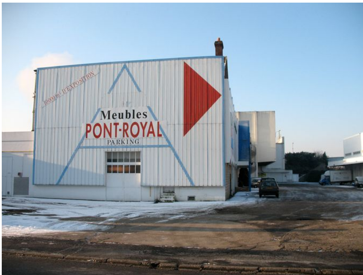
Cour de livraison et parking du magasin Pont-Royal situés 33 rue Carnot.
