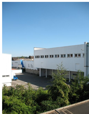
Bâtiments de stockage et magasin d'exposition depuis le pont Royal. Phot. Clarisse Lorieux IVR22_20096005120NUCA
