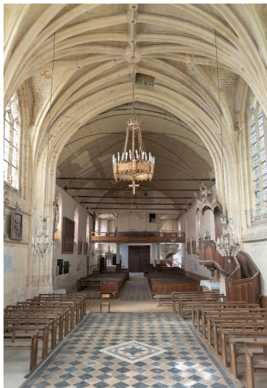
Vue vers la nef. Phot. Marc Kérignard IVR32_20236000473NUCA
