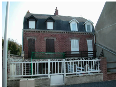
Vue d'ensemble depuis l'impasse Adolphe Roux. Phot. Elisabeth Justome IVR22_20058003649NUCA
