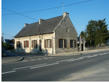
Vue du mur-pignon. Phot. Inès Guérin IVR22_20030202308NUCA
