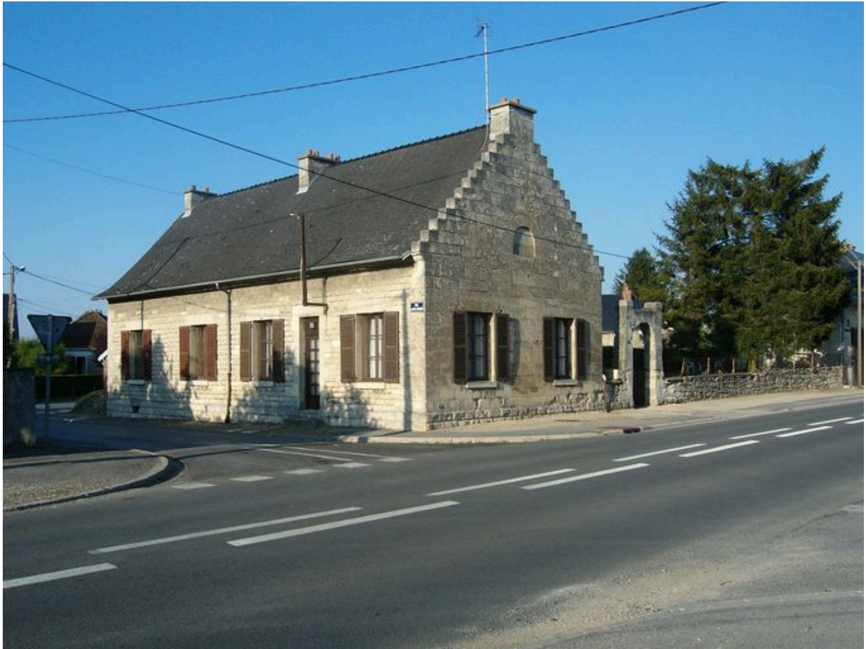
Vue du mur-pignon.
