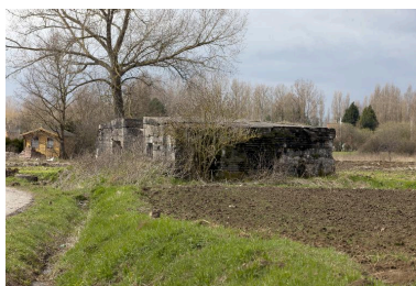
Vue générale vers l'ouest, depuis la rue du Bois Leval. Phot. Jean-Marc Ramette IVR31_20145904067NUCA
