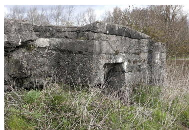
Elévation sud, entrée est Phot. Jean-Marc Ramette IVR31_20145904059NUCA
