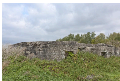
Elévation sud, ver le nord-est Phot. Jean-Marc Ramette IVR31_20145904066NUCA
