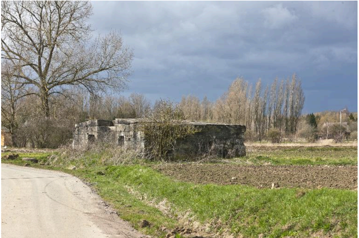
Vue générale vers l'ouest, depuis la rue du Bois Leval.
