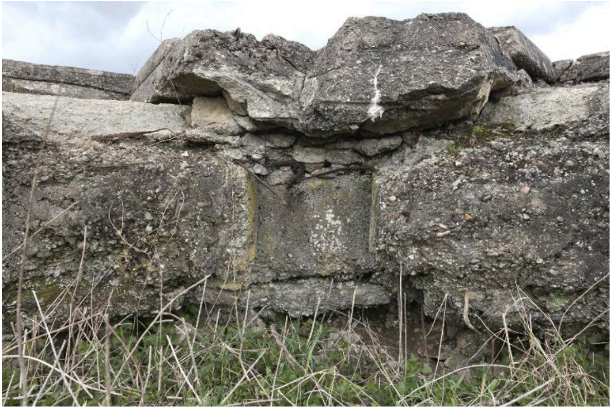
Elévation sud, partie centrale
