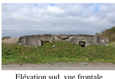
Elévation sud, vue frontale Phot. Jean-Marc Ramette IVR31_20145904077NUCA
