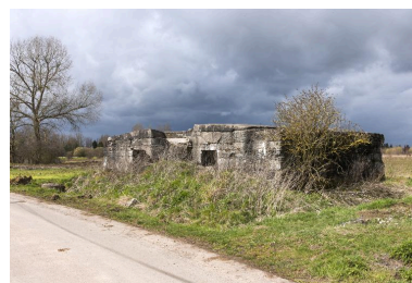
Vue générale vers l'ouest, depuis la rue du Bois Leval. Phot. Jean-Marc Ramette IVR31_20145904058NUCA
