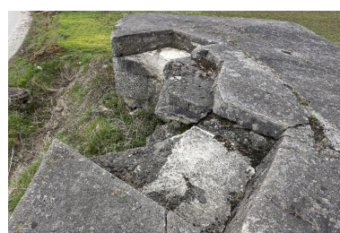
Depuis le toit, le logements des armes et l'emplacement disparu de la banquette de tir Phot. Jean-Marc Ramette IVR31_20145904074NUCA
