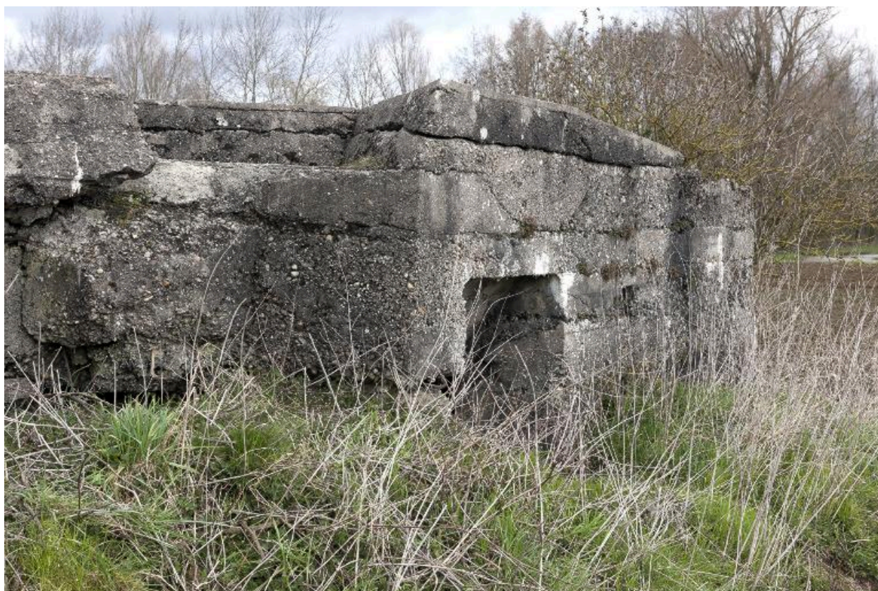
Elévation sud, entrée est
