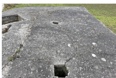
Depuis le toit, vue des sorties de cheminée périscopiques Phot. Jean-Marc Ramette IVR31_20145904064NUCA
