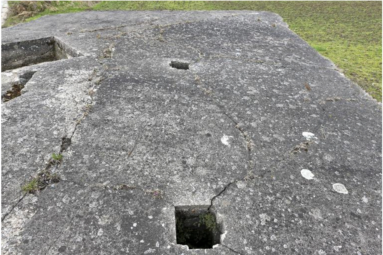
Depuis le toit, vue des sorties de cheminée périscopiques
