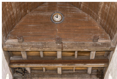
Vue du premier étage du clocher avec blochets sculptés. Phot. Marc Kérignard IVR32_20216000657NUCA
