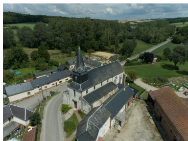
Vue générale aérienne de l'église depuis le sud-ouest. Phot. Marc Kérignard IVR32_20216000778NUCA
