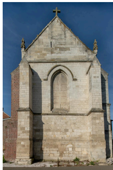
Vue du chevet plat avec sa baie aveugle. Phot. Marc Kérignard IVR32_20216000927NUCA
