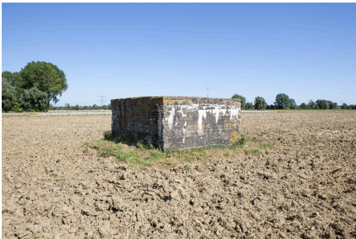
Vue de trois-quarts, vers le sud-est
