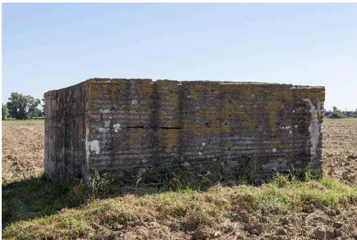
Vue de trois-quarts vers le sud
