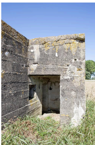
Vue vers le nord. Entrée pare-souffle Phot. Pierre Thibaut IVR32_20165901372NUCA
