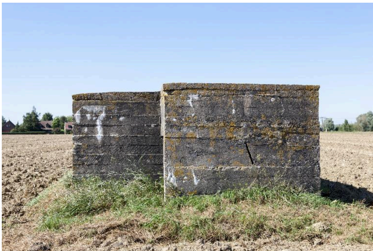
Vue latérale vers le nord-ouest
