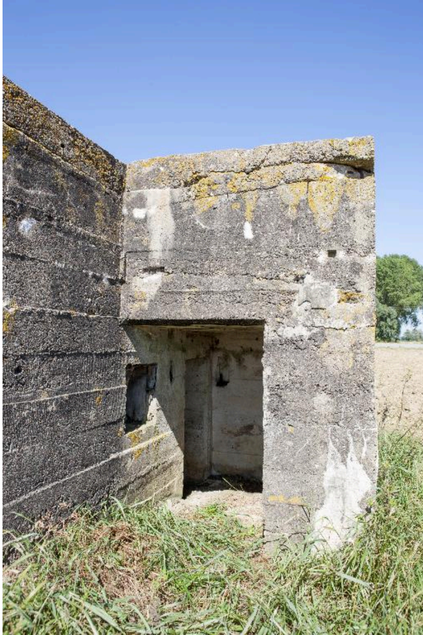
Vue vers le nord. Entrée pare-souffle
