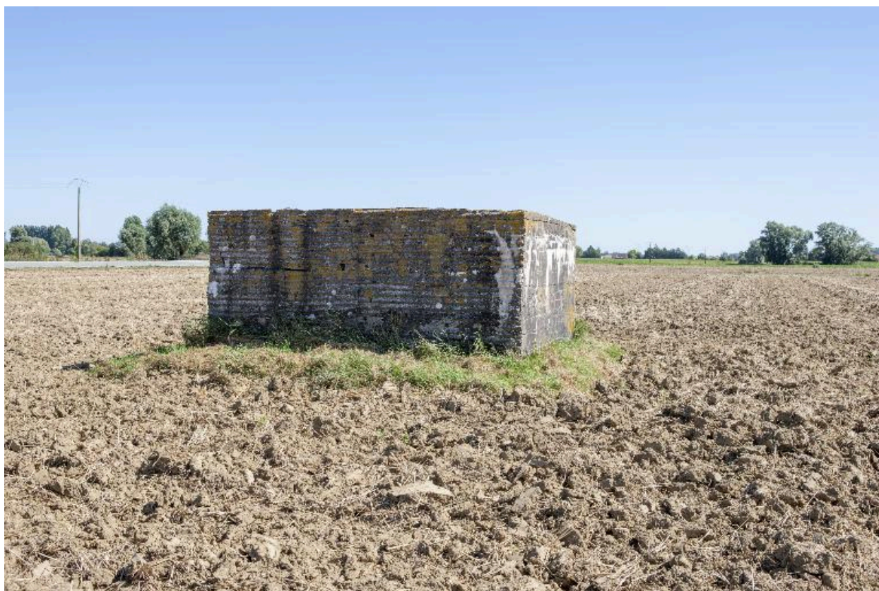
Vue générale, vers l'est
