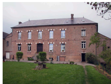
Façade sur jardin du logement patronal. Phot. Bertrand Fournier IVR22_20056000811NUCA
