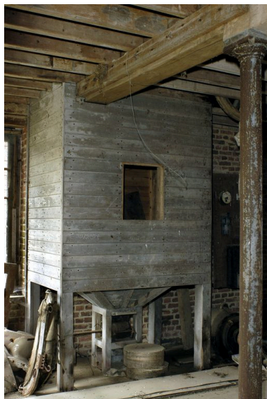
Silo rectangulaire en bois. Phot. Thierry Lefébure IVR22_20056000070NUCA
