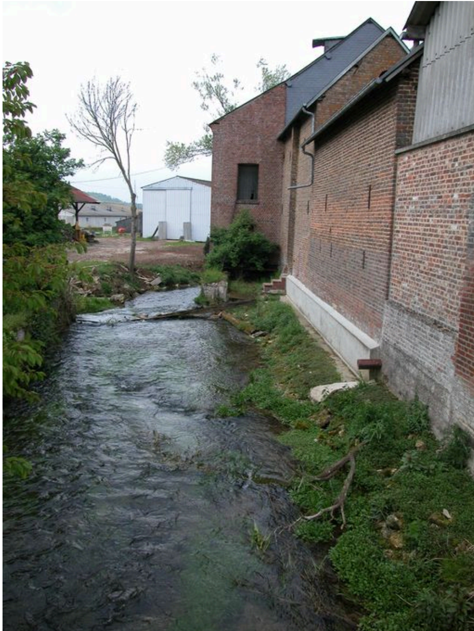
La rivière longeant les bâtiments de la minoterie, en amont de la chute.
