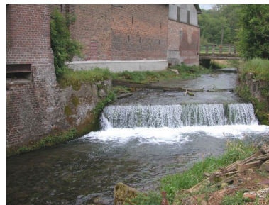
Les vestiges du vannage de décharge et la chute du moulin. Phot. Bertrand Fournier IVR22_20056000813NUCA
