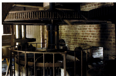
Le beffroi et les grands rouets de transmission. Phot. Thierry Lefébure IVR22_20056000069NUCA
