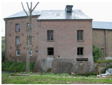
Vue d'ensemble, façade sur rivière. Phot. Bertrand Fournier IVR22_20056000809NUCA
