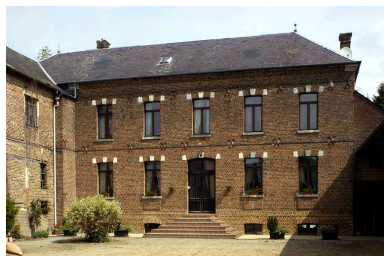
Le logement patronal, façade sur cour. Phot. Thierry Lefébure IVR22_20056000064NUCA
