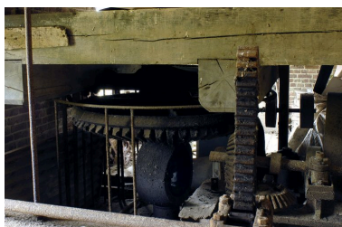
Engrenages de transmission situés au-dessus de la turbine. Phot. Thierry Lefébure IVR22_20056000067NUCA
