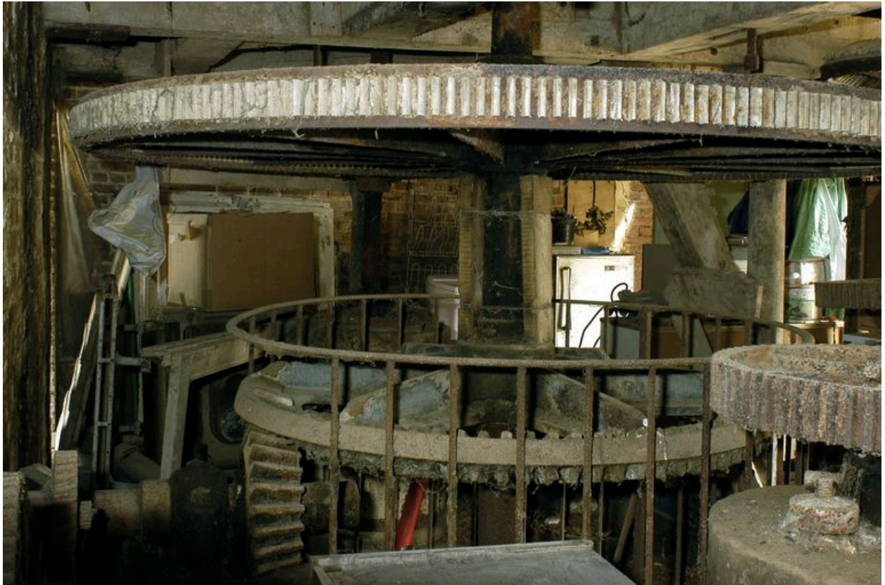
Le beffroi du moulin et les grands rouets de transmission.
