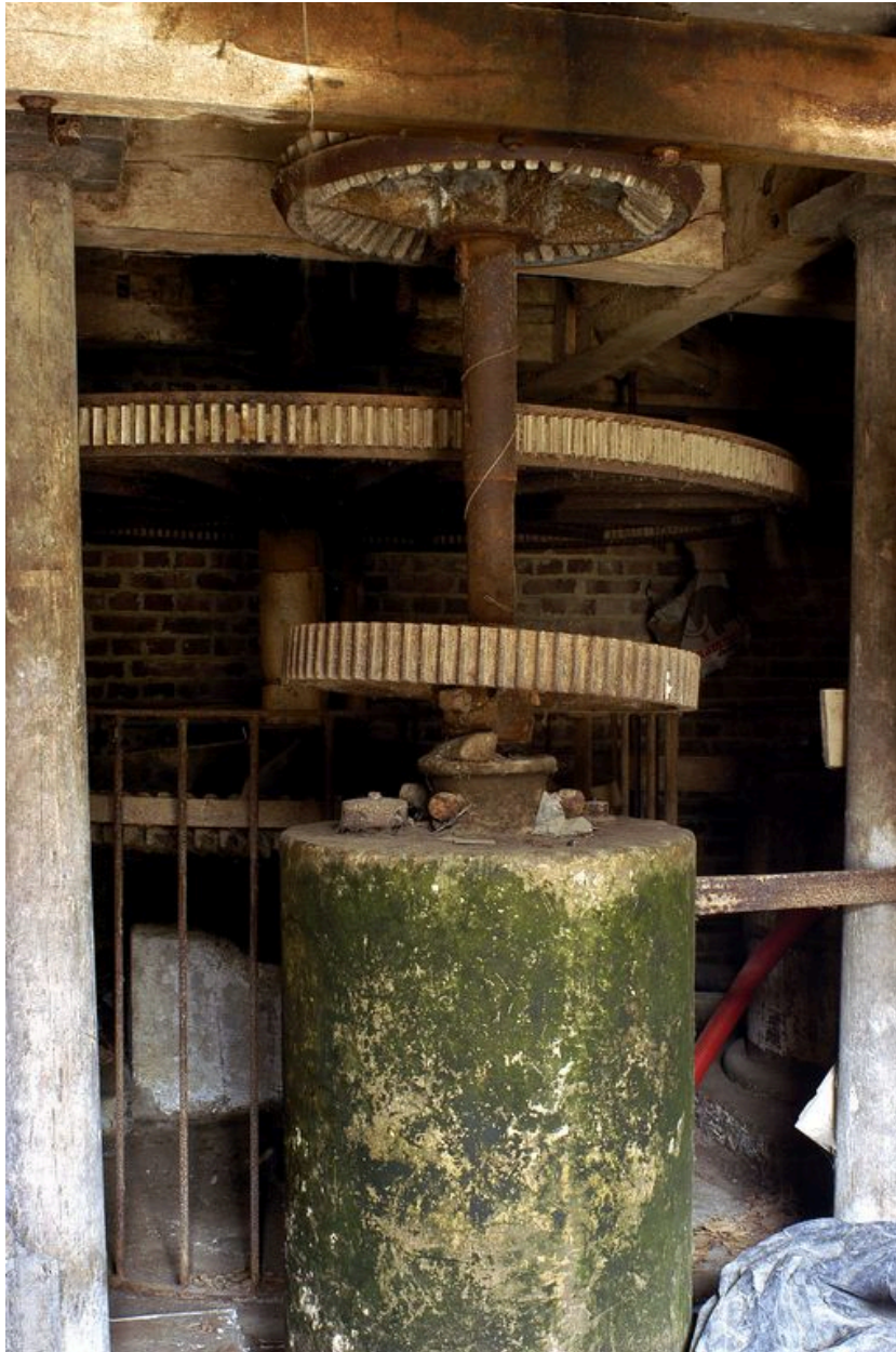
Détail des engrenages de transmission vers l'une des meules du premier étage.
