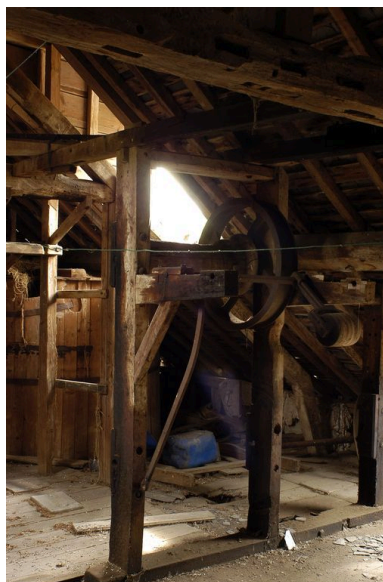
Treuil monte-sac. Phot. Thierry Lefébure IVR22_20056000079NUCA
