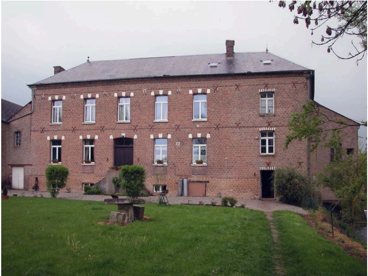
Façade sur jardin du logement patronal.
