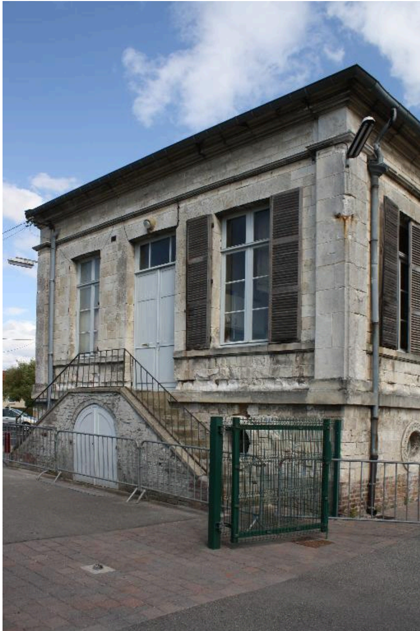
Vue du pignon ouest du logement de l'ancienne école de garçons.
