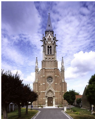
Vue générale. Phot. Thierry Lefébure IVR22_20038000702VA
