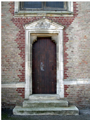
Vue de détail : porte nord. Phot. Isabelle Barbedor IVR22_20068010210NUCA
