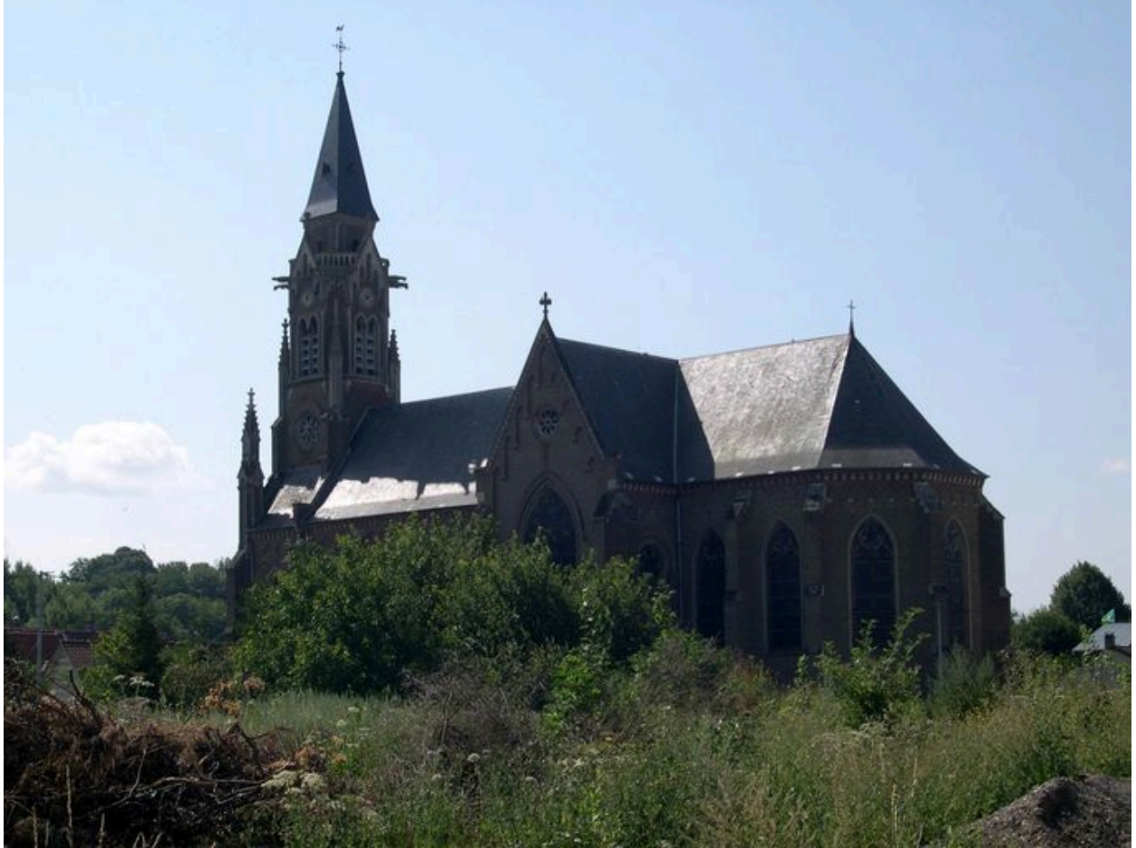
Vue de situation depuis le nord-ouest.
