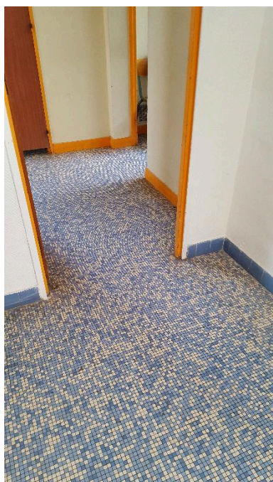
Détail du revêtement en micro-mosaïque (nuances de bleu et blanc) dans les locaux annexes (bureau du maître-nageur).
