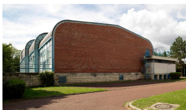
Pignon est (façade arrière de la piscine), avec escalier de secours. Phot. Marie-Laure Monnehay-Vulliet IVR32_20176000001NUC2A
