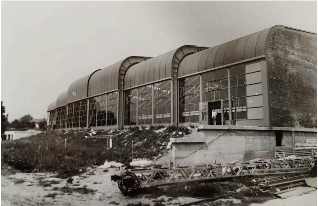
Vue de la piscine en construction, façade sud. Juillet 1967. Photo : Société MacGregor-Comarain (AN ; 19840036/145).
