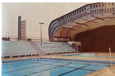
Vue de la piscine de Noyon découverte. Issue de la brochure de présentation réalisée par la société MacGregor-Comarain. Photo : H. Bernard (AN ; 19940528/1). Phot. Laurence Schlosser (reproduction) IVR32_20176005013NUCA
