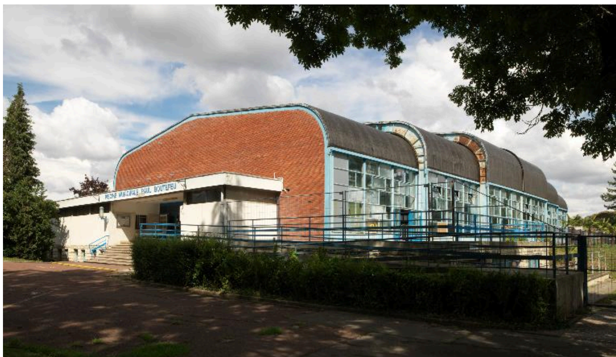
Vue de l'entrée (pignon ouest) et de la façade sud.
