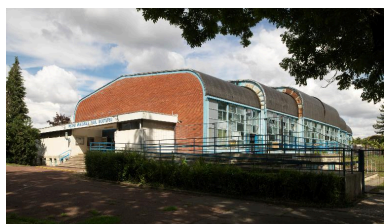
Vue de l'entrée (pignon ouest) et de la façade sud. Phot. Marie-Laure Monnehay-Vulliet IVR32_20176000002NUC2A
