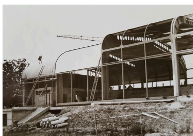
Vue du pignon d'entrée de la piscine en travaux. Juillet 1967. Photo : Société MacGregor-Comarain (AN ; 19840036/145). Phot. Laurence Schlosser (reproduction) IVR32_20176005032NUCA
