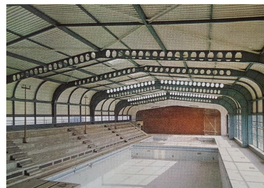
Vue de la piscine couverte, avant sa mise en eaux. Issue de la brochure de présentation de la piscine par la société MacGregor-Comarain. Photo : H. Bernard (AN ; 19940528/1). Phot. Laurence Schlosser (reproduction) IVR32_20176005012NUCA
