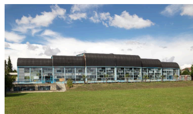
Vue générale de la façade sud, donnant sur une terrasse et une pelouse (servant de solarium et d'aire de jeux aux beaux jours). Phot. Marie-Laure Monnehay-Vulliet IVR32_20176000008NUC2A
