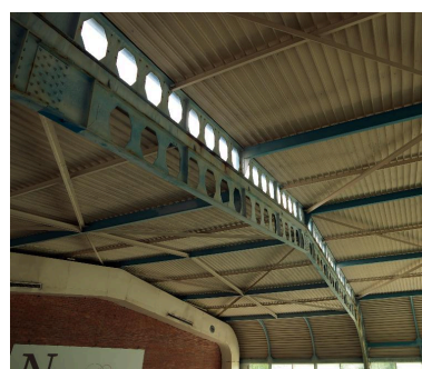
Détail des fermes métalliques percées d'ouvertures octogonales de la structure mobile.
