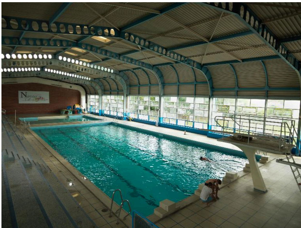
Vue générale des bassins et du plongeur.
