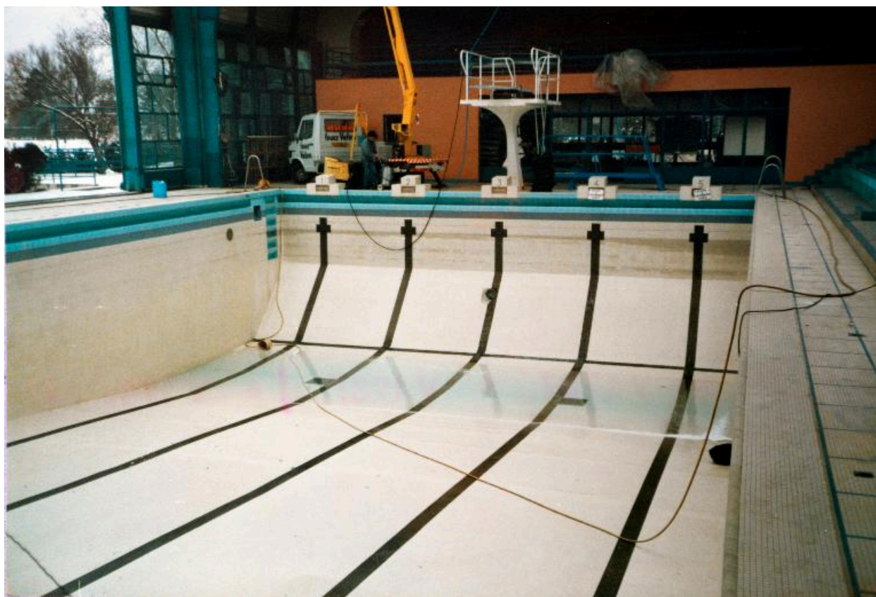
Vue du bassin sportif vide (3,5 mètres de profondeur) lors de travaux, vers 1990 (archives de la piscine).
