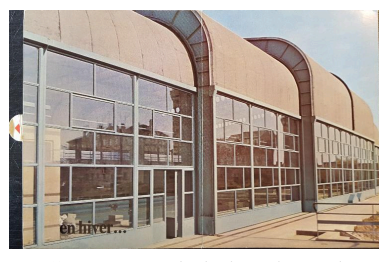
Couverture de la brochure de présentation de la piscine de Noyon produite par la société MacGregor-Comarain. Photo : H. Bernard (AN ; 19940528/1). Phot. Laurence Schlosser (reproduction) IVR32_20176005009NUCA
