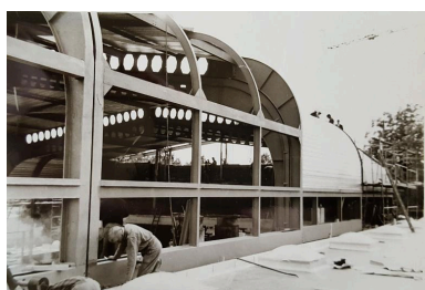
Détail de la structure mobile depuis l'extérieur. Vue de chantier. Juillet 1967. Photo : Société MacGregor-Comarain (AN ; 19840036/145). Phot. Laurence Schlosser (reproduction) IVR32_20176005034NUCA
