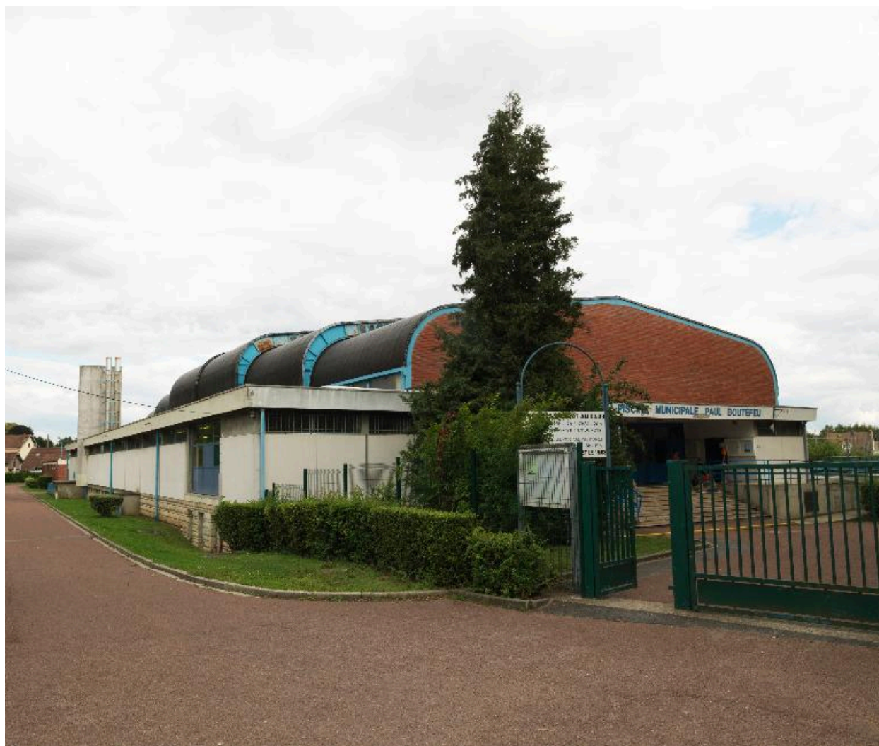
Entrée de la piscine et façade nord (prolongée par une salle de musculation, et en sous-sol, les locaux de la machinerie).).
