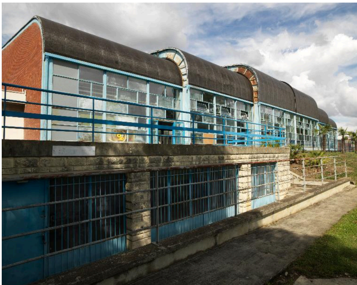
Vue générale de la façade sud, avec au premier plan l'ancien stand de tir, dont le toit sert de terrasse à la piscine.
