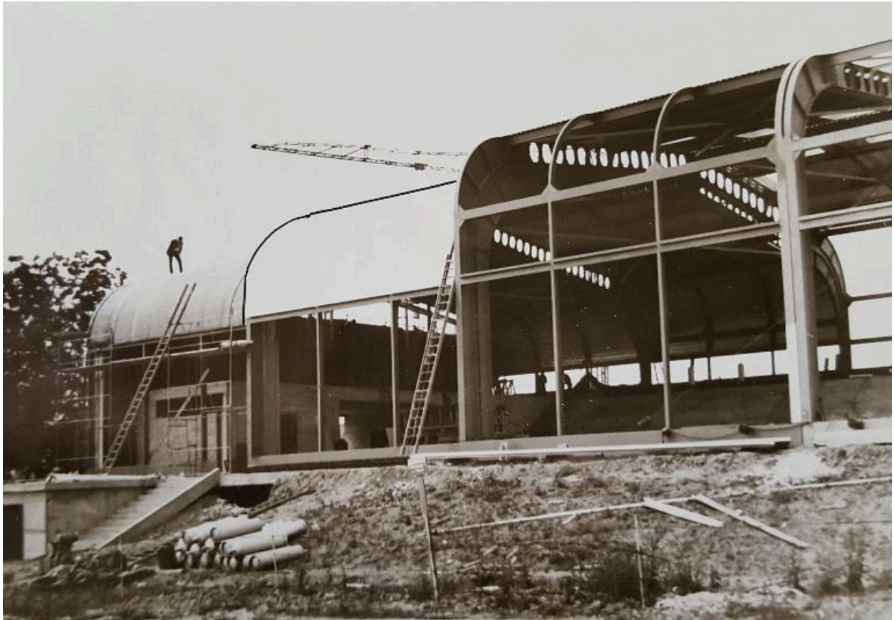
Vue du pignon d'entrée de la piscine en travaux. Juillet 1967. Photo : Société MacGregor-Comarain (AN ; 19840036/145).
