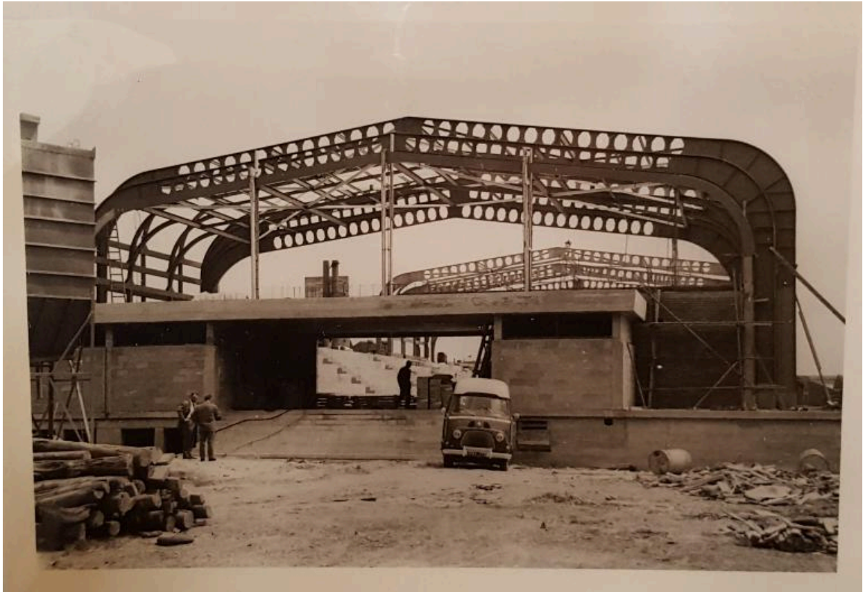
Photo de la piscine en construction, vue sur l'entrée, côté ouest, juin 1967. Photo : Société MacGregor-Comarain (AN ; 19940528/1).
