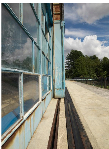
Détail de la structure mobile et des rails permettant aux éléments de glisser et de s'emboîter les uns au dessus des autres. Phot. Marie-Laure Monnehay-Vulliet IVR32_20176000007NUC2A
