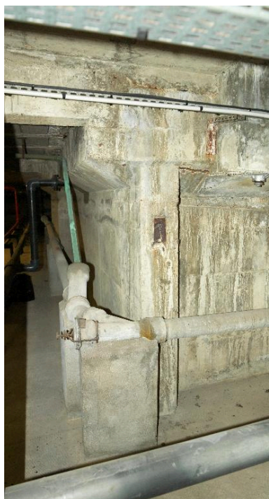
Galerie technique, vue de la cuve en béton armé du petit bassin. Phot. Marie-Laure Monnehay-Vulliet IVR32_2017600014NUC2A
