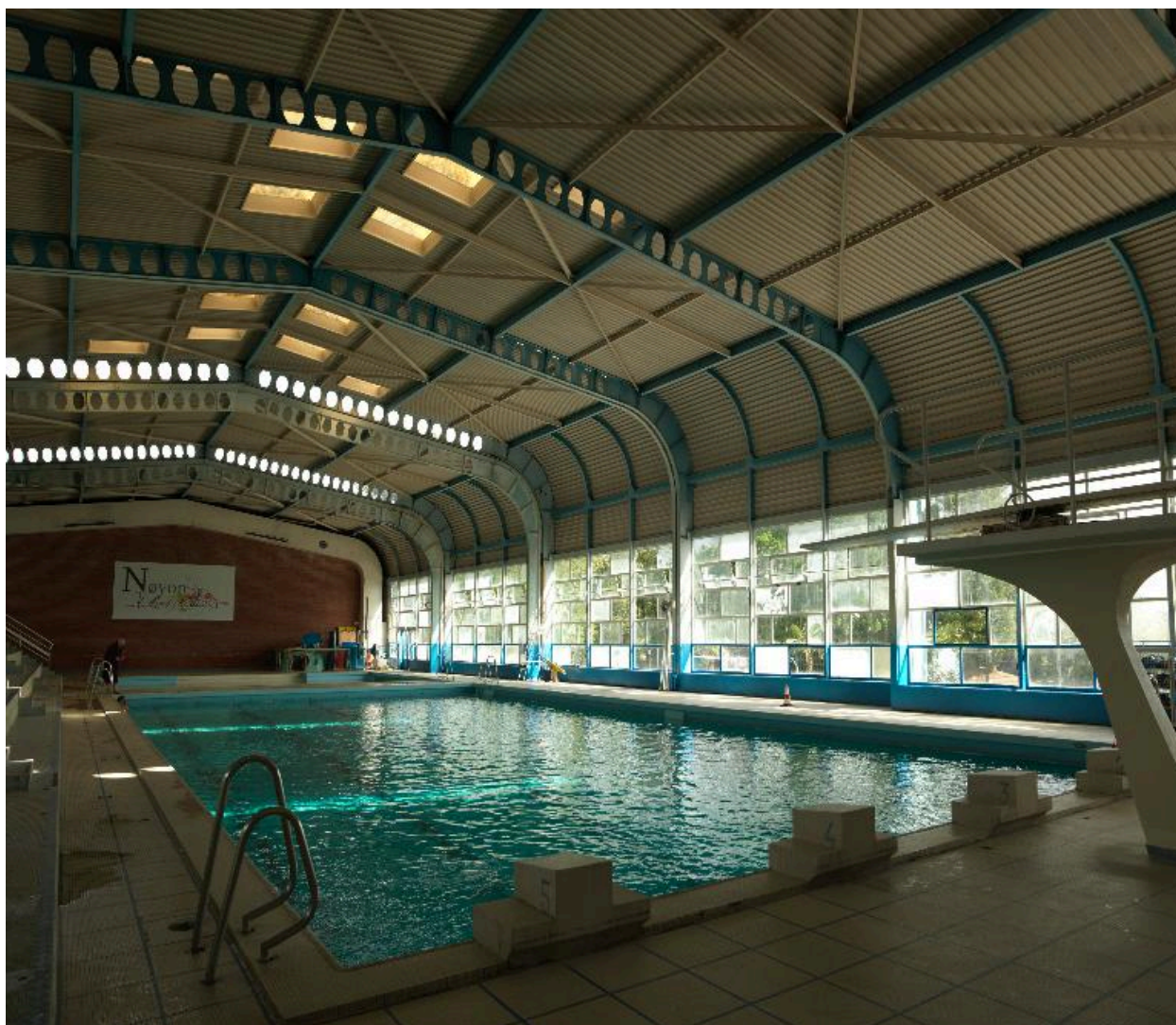
Vue générale des bassins et de la façade sud s'ouvrant sur le solarium.
