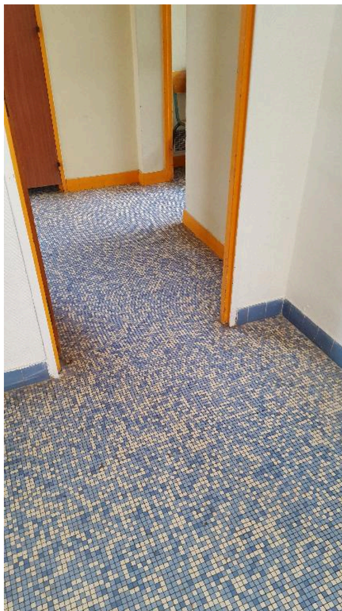
Détail du revêtement en micro-mosaïque (nuances de bleu et blanc) dans les locaux annexes (bureau du maître-nageur).
