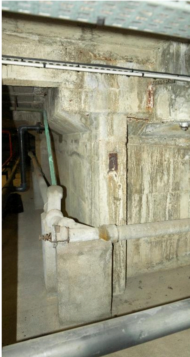
Galerie technique, vue de la cuve en béton armé du petit bassin.
