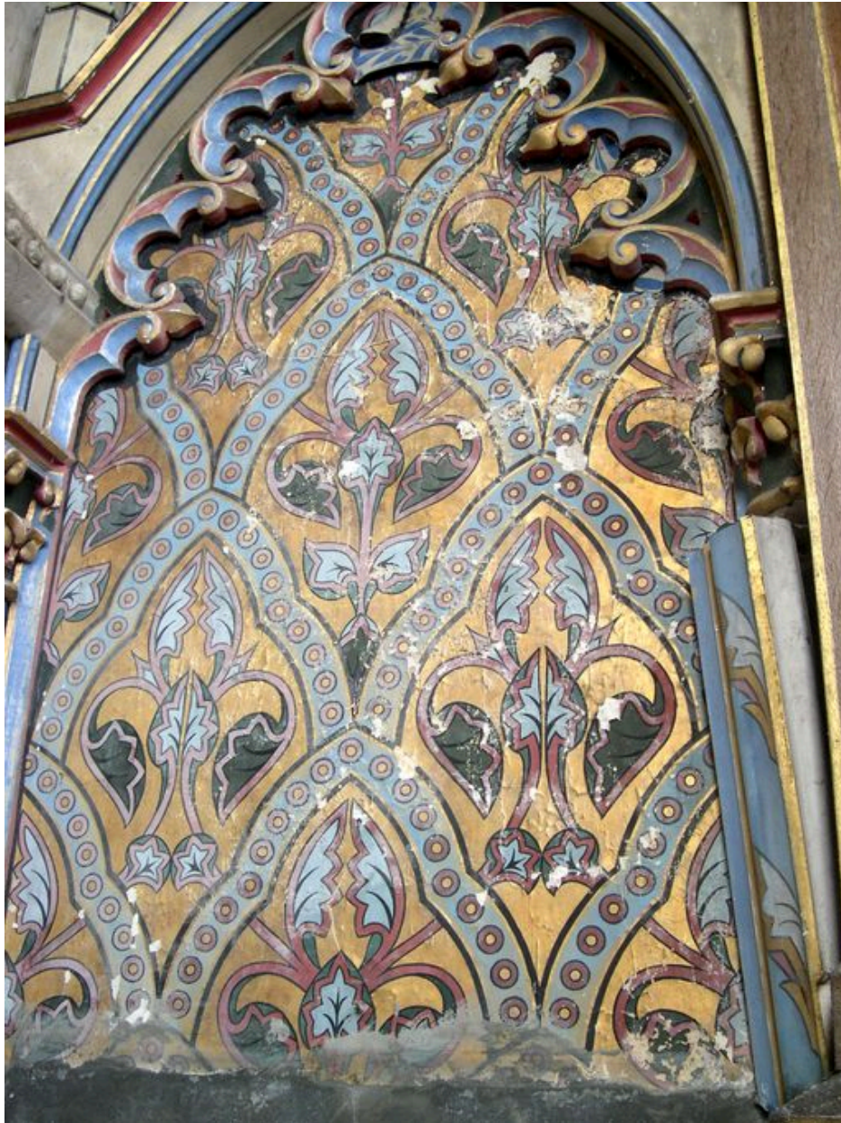
Vue du décor polychrome du mur ouest du transept nord.
