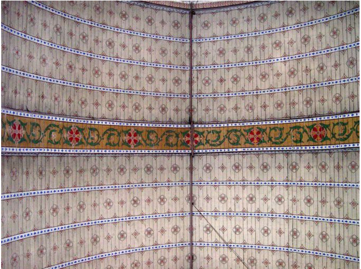
Vue du lambris de couverture du chœur.
