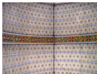
Vue du lambris de couvrement du chœur. Phot. Isabelle Barbedor IVR22_20068010253NUCA
