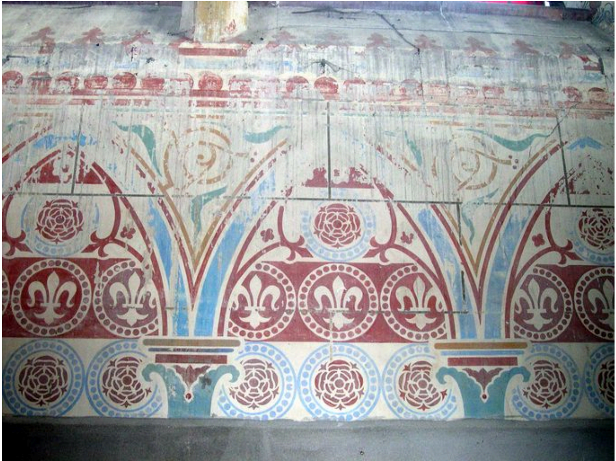
Vue du décor polychrome du mur nord du transept nord.
