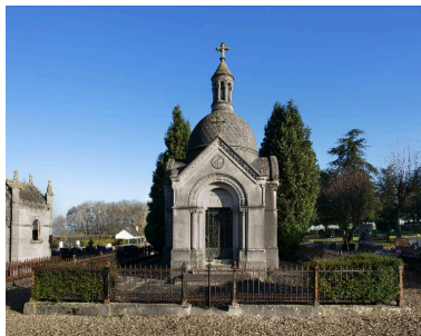
Vue générale. Phot. Thierry Lefébure IVR22_20138000557NUC2AQ
