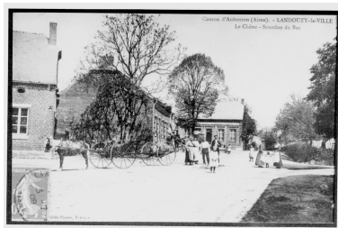
Vue des fermes à l'entrée du hameau du Chêne-Bourdon-de-Bas, depuis le carrefour (AP). Phot. Pierre-Yves Brest (reproduction) IVR22_19980202488ZB
