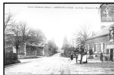
Vue des fermes à l'entrée du hameau du Chêne-Bourdon-de-Bas (AP). Phot. Pierre-Yves Brest (reproduction) IVR22_19980202489ZB
