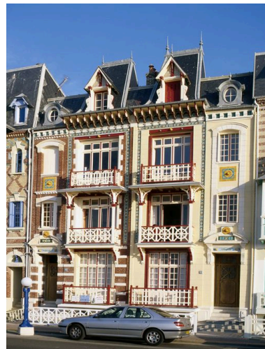
Vue d'ensemble depuis l'esplanade, état après restauration (2004). Phot. Marie-Laure Monnehay-Vulliet IVR22_20048000294XA
