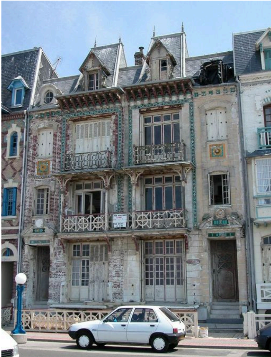
Vue d'ensemble depuis l'esplanade, état avant restauration (2003).
