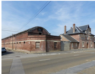
Vue générale depuis la rue Henri-Martin. Phot. Isabelle Barbedor IVR32_20170205612NUCA
