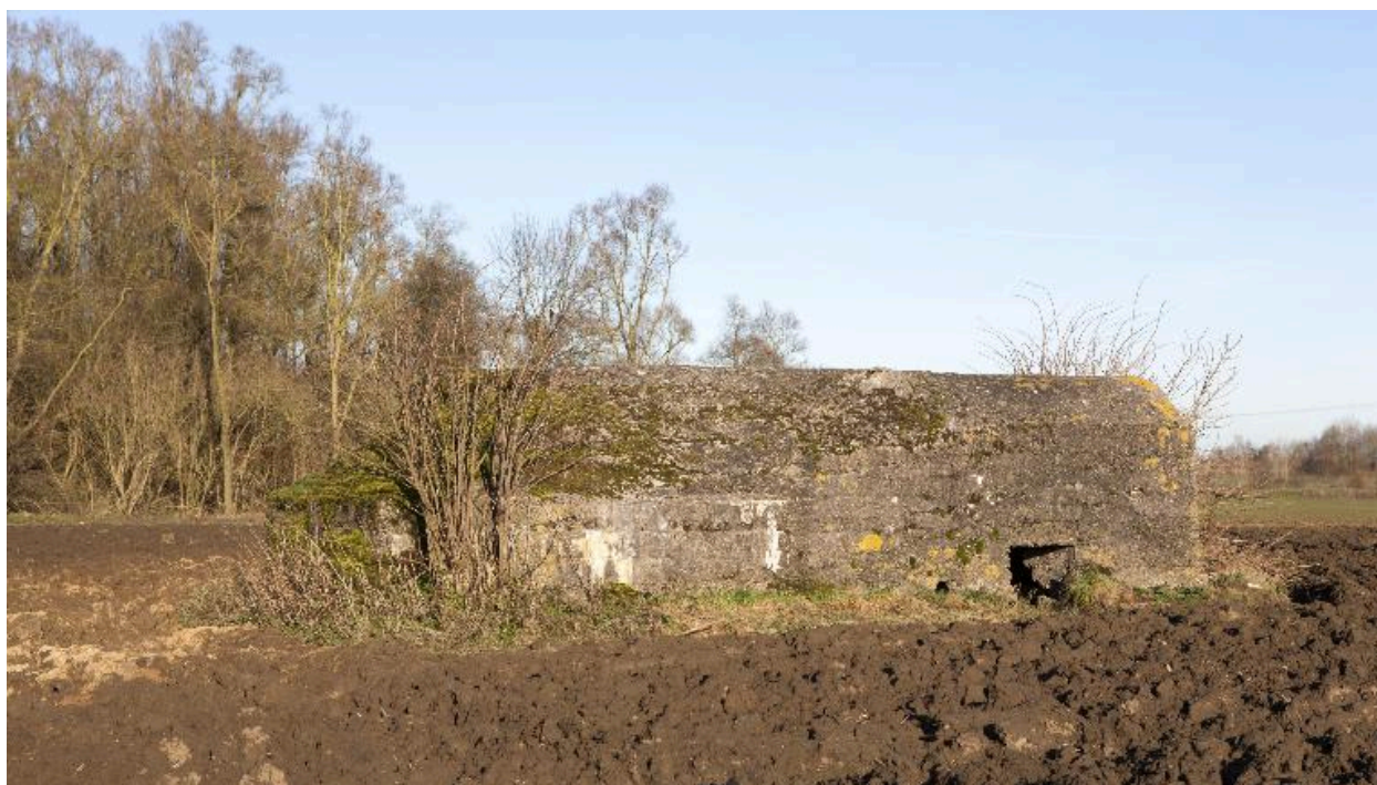
Vue latérale, vers le nord-est
