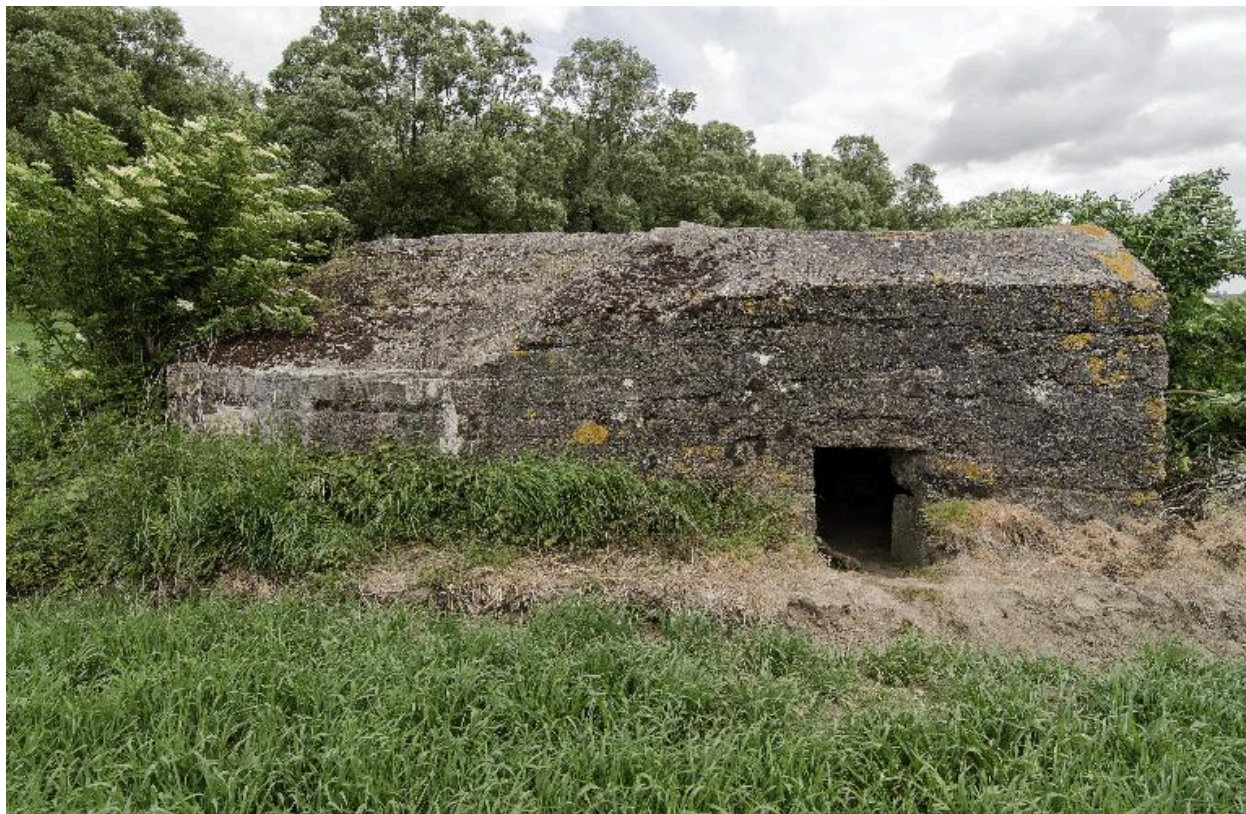
Vue latérale vers le nord-est. Entrée
