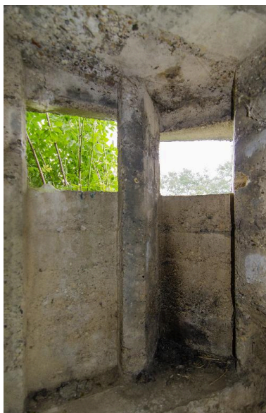
Intérieur du poste d'observation (au grand angulaire) Phot. Jean-Marc Ramette IVR32_20165901155NUCA
