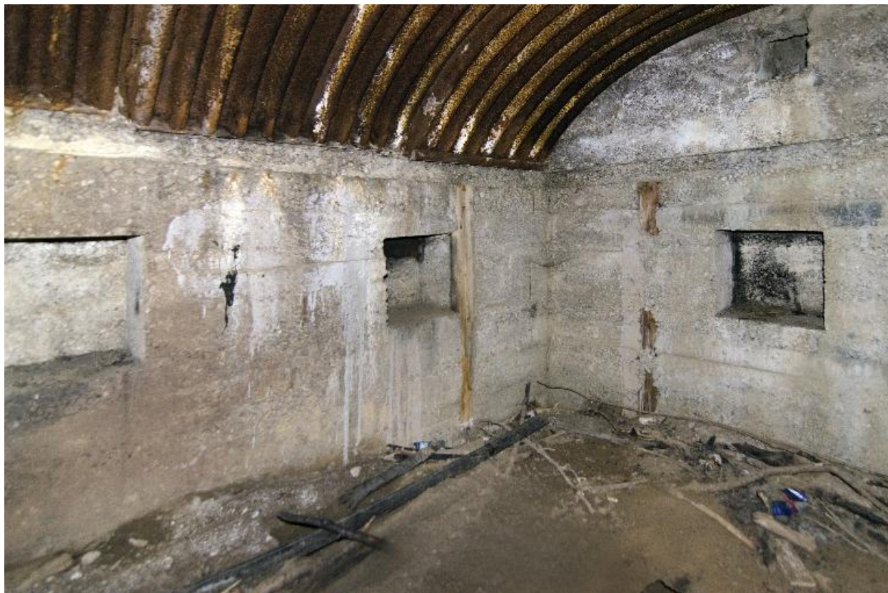
Abri à personnel, vue intérieure, mur sud-ouest (au grand angulaire)
