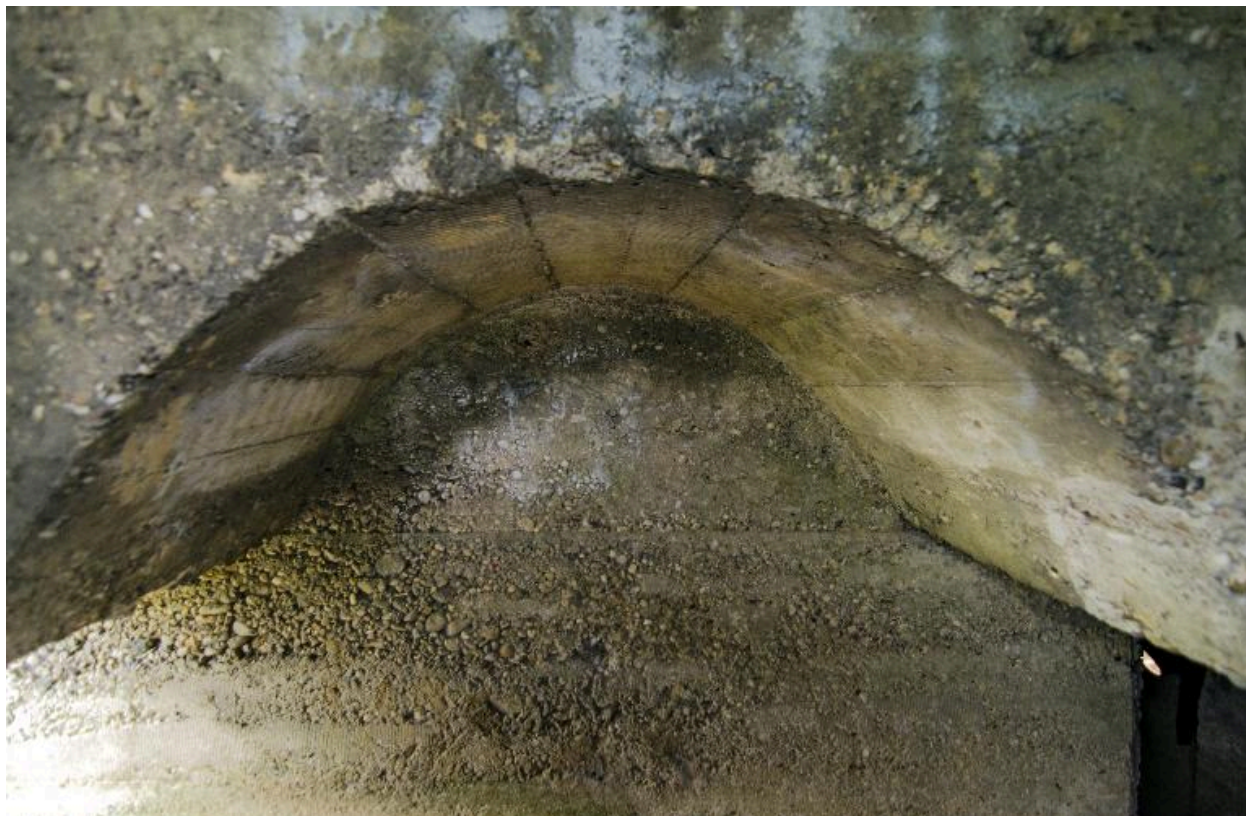
Sortie du poste d'observation. Voûte transversale, au couloir de distribution (au grand angulaire)
