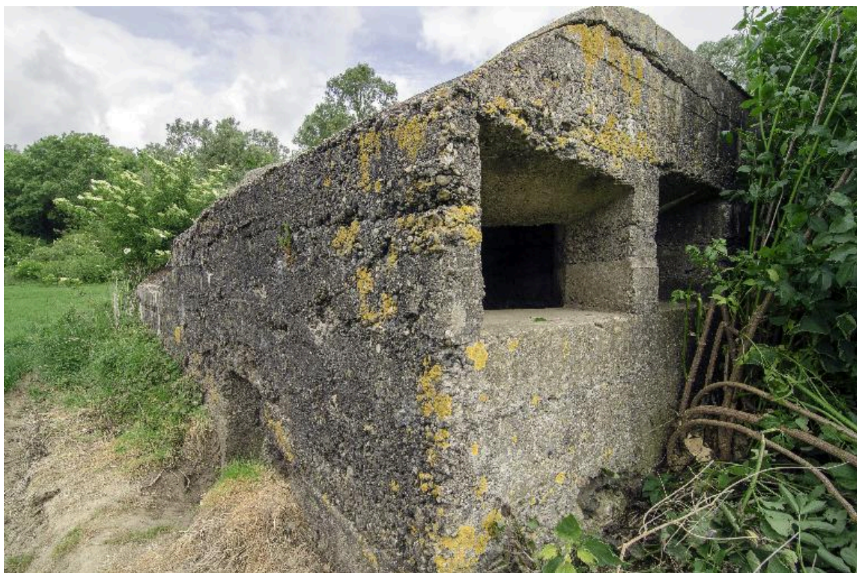
Vue générale vers nord
