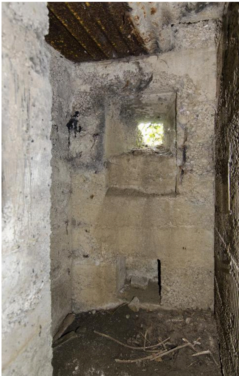
Créneau de fusillade vers le sud-ouest
