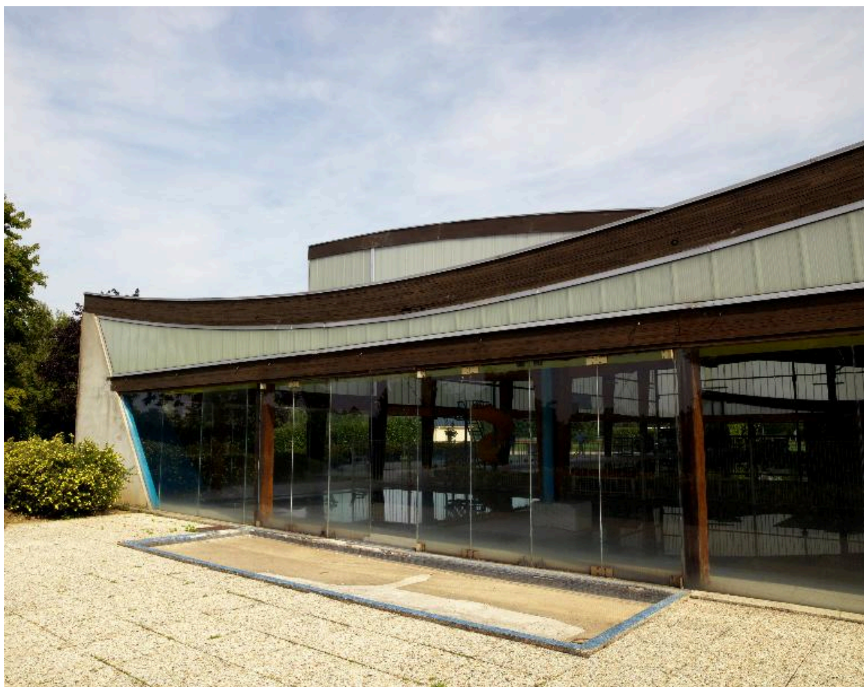
Pédiluve extérieur, longeant la façade vitrée de la pataugeoire.
