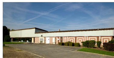
Façade est, correspondant au bloc d'annexes (avec entrée du local chaufferie) et au petit bassin. Phot. Marie-Laure Monnehay-Vulliet IVR32_20170200351NUCA
