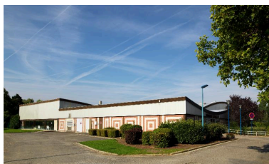
Façades nord et est (bloc d'annexes et du petit bassin). Phot. Marie-Laure Monnehay-Vulliet IVR32_20170200305NUCA
