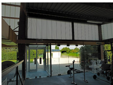
Entrée secondaire (accessible depuis le mini-golf en été). Phot. Marie-Laure Monnehay-Vulliet IVR32_20170200313NUC2A
