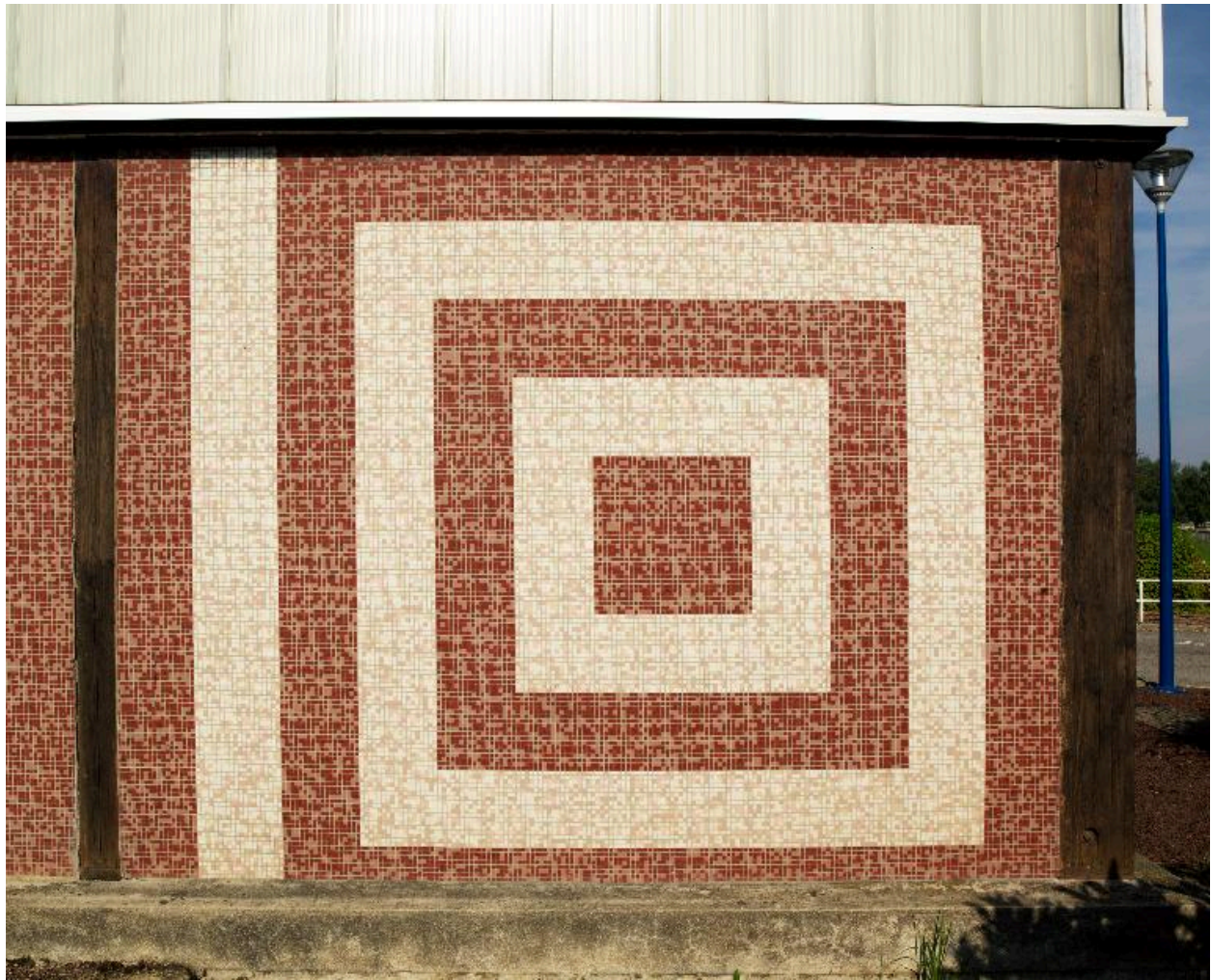
Détail de la fresque de carrés concentriques en mosaïque ornant les façades du bloc d'annexes.
