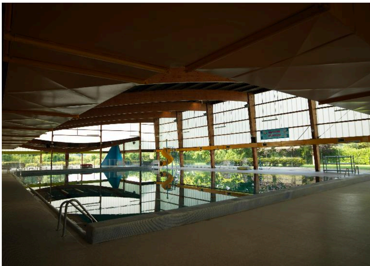
Vue générale du bassin sportif, depuis le "foyer".
