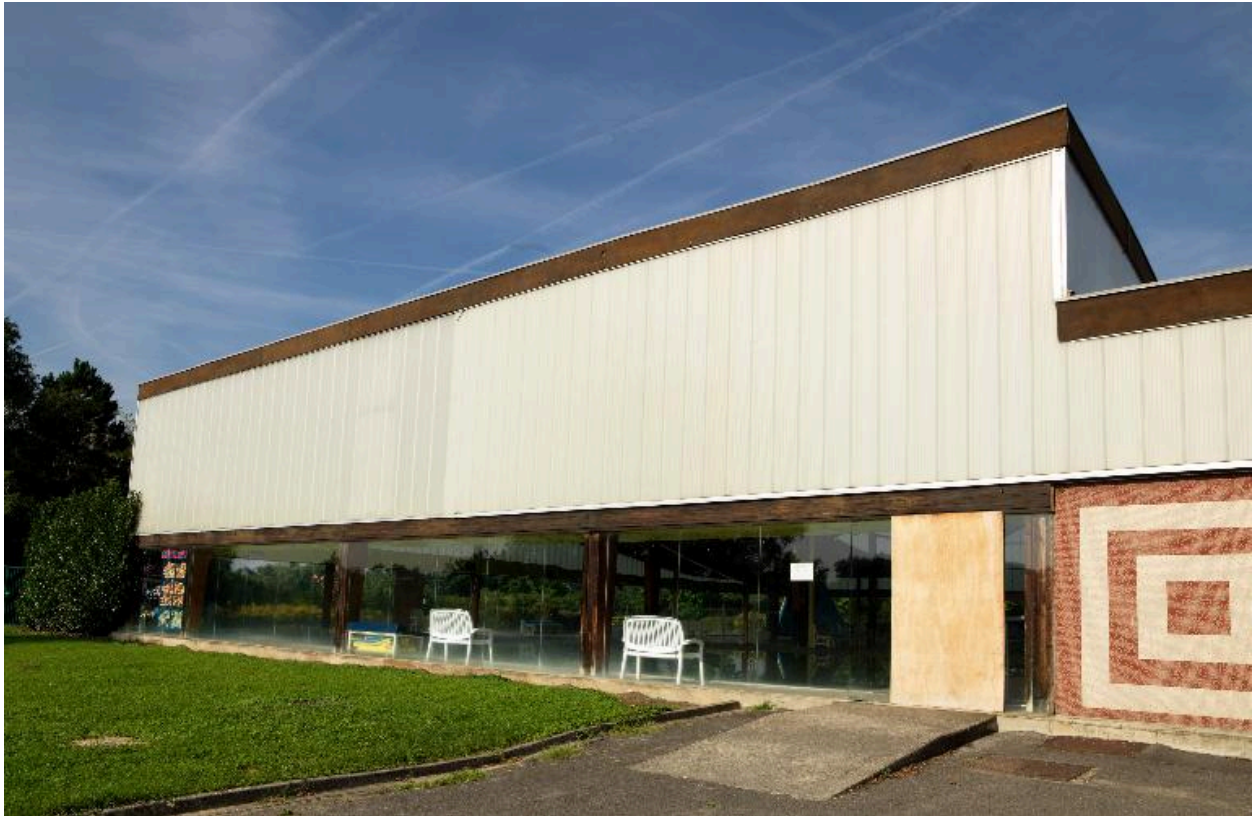
Façade donnant sur le petit bassin (est).
