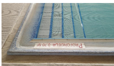
Détail des marches d'accès au bassin d'apprentissage. Phot. Laurence Schlosser IVR32_20170205373NUCA
