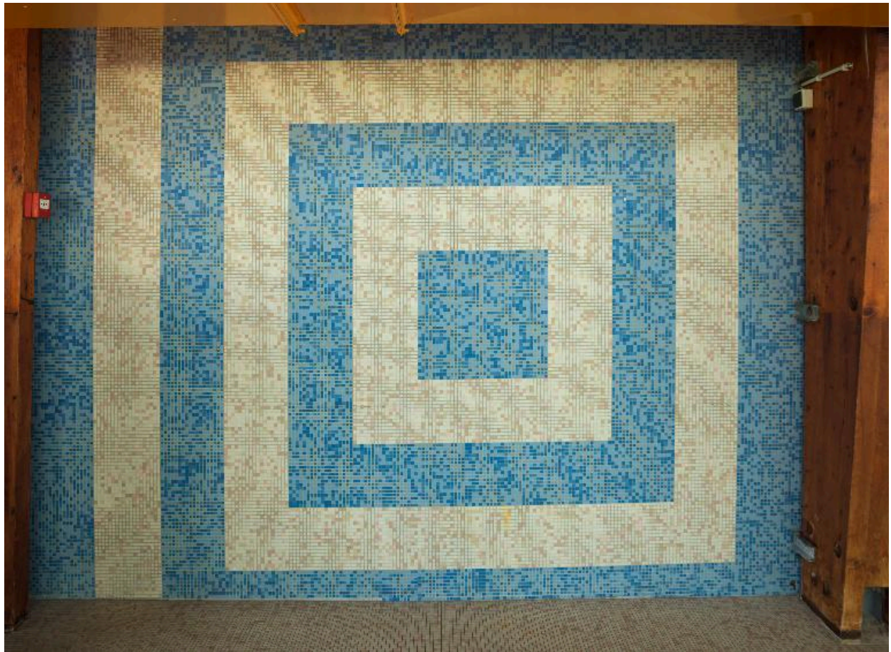
Détail des décors de carrés concentriques en mosaïque qui ornent les cloisonnement intérieurs du hall des bassins.
