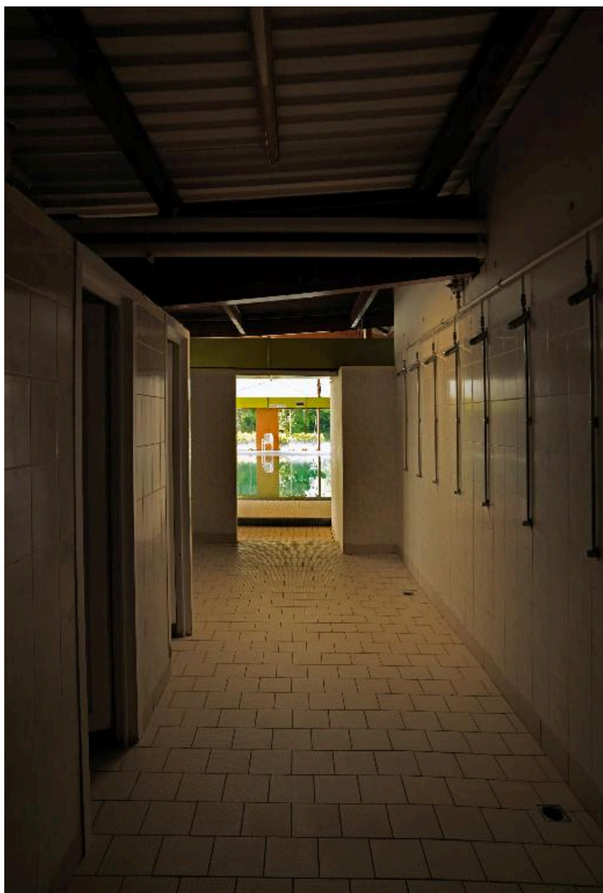
Vue des douches, vers le bassin d'apprentissage.
