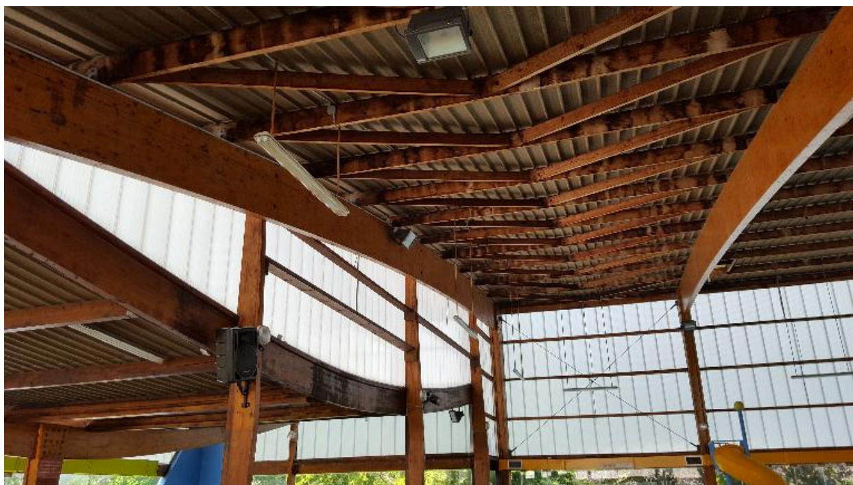
Détail de la charpente.
