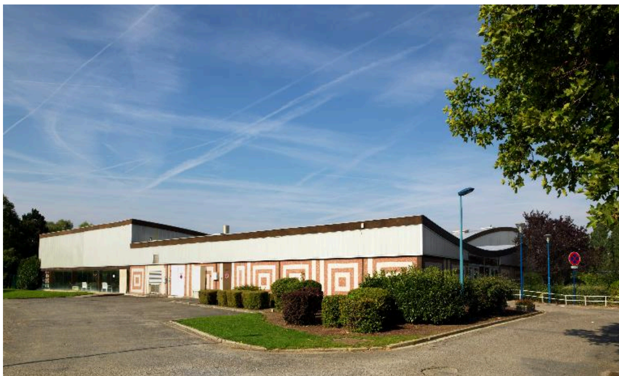
Façades nord et est (bloc d'annexes et du petit bassin).
