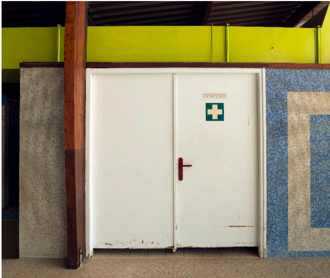
Entrée local infirmerie et rangement matériel de secours.
