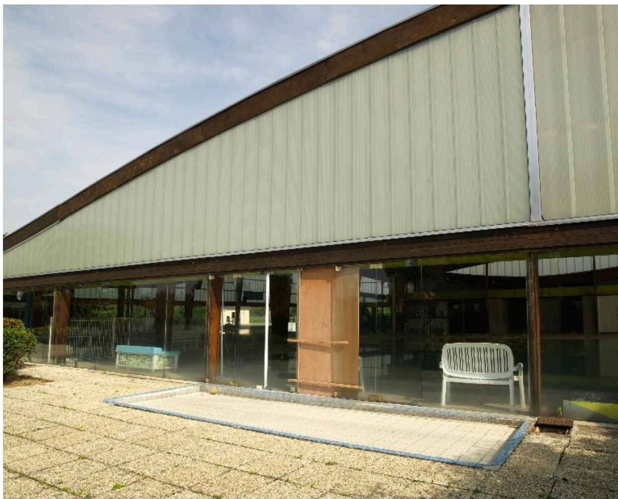
Détail d'un des pédivules extérieurs, donnant accès aux terrasses et pelouses.
