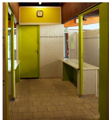
Local porte-habits, avec accès de part et d'autre sur les vestiaires femmes et hommes. Phot. Marie-Laure Monnehay-Vulliet IVR32_20170200333NUC2A
