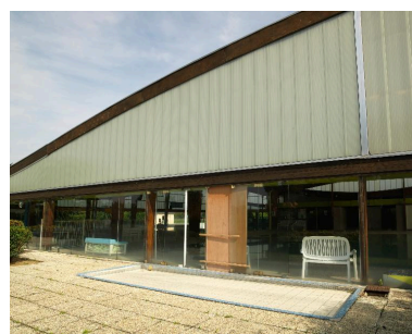
Détail d'un des pédiluves extérieurs, donnant accès aux terrasses et pelouses. Phot. Marie-Laure Monnehay-Vulliet IVR32_20170200348NUCA
