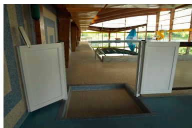
Pédiluve d'accès entre les bassins et le "foyer". Phot. Marie-Laure Monnehay-Vulliet IVR32_20170200314NUC2A
