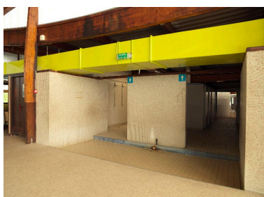
Pédiluve d'accès aux bassins depuis les douches et les vestiaires. Phot. Marie-Laure Monnehay-Vulliet IVR32_20170200320NUC2A
