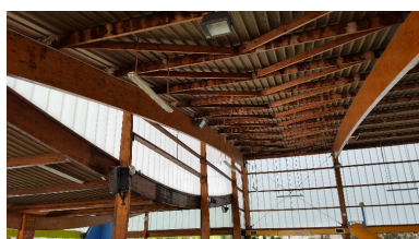
Détail de la charpente. Phot. Laurence Schlosser IVR32_20170205372NUCA
